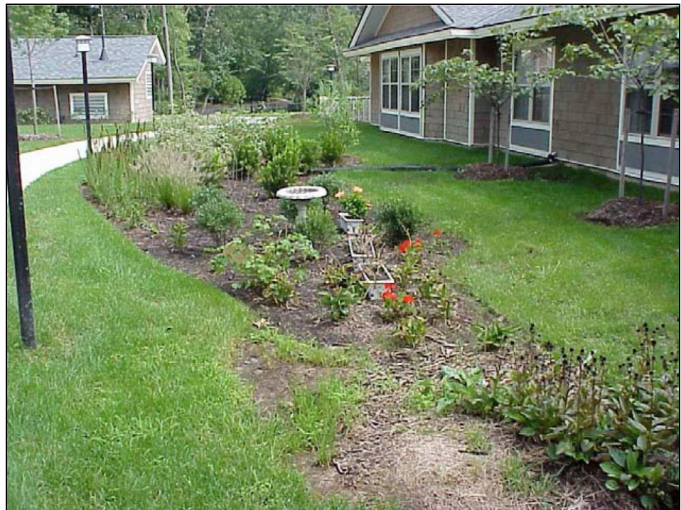
Kuva 29. Sadepuutarha piha- ja kattovesille 10 .
