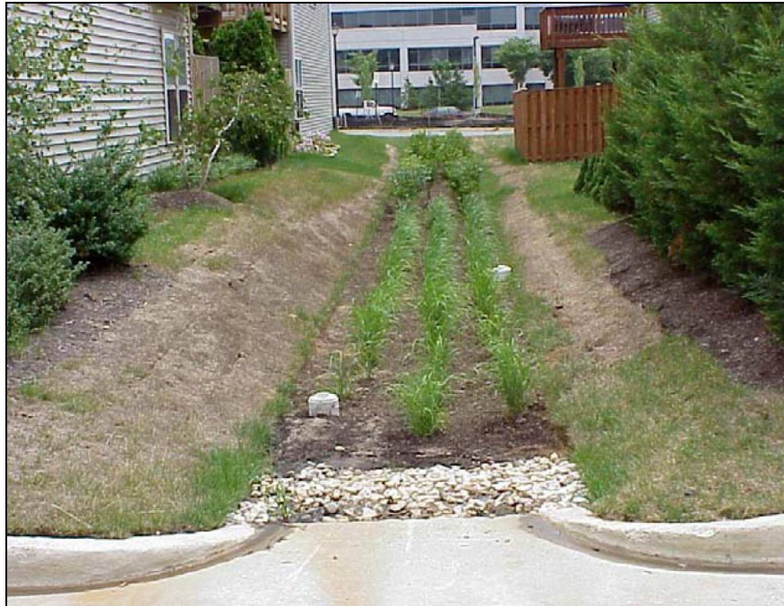
Kuva 32. Useampaa kiinteistöä palveleva imeytyskaivanto 10 .
