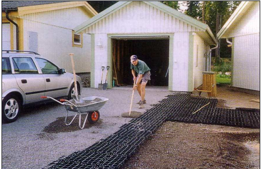
Kuva 33. Kennosorapinnan rakentamista 14 .
