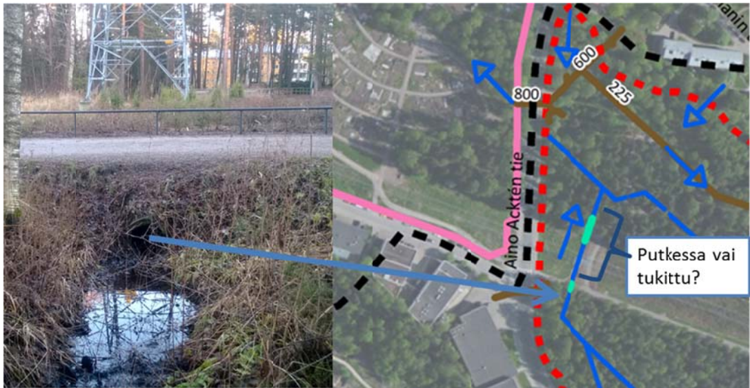
Kuva 44. Puiston länsiosassa kantakartan perusteella ulkoilureitin alittava uoma jatkuu voimalinjan pylvään alta. Maastossa uomaa ei näy eikä verkostokartan perusteella kulje putkitettunakaan. Kuvaushetkellä vesi seisoï putken edustalla.
