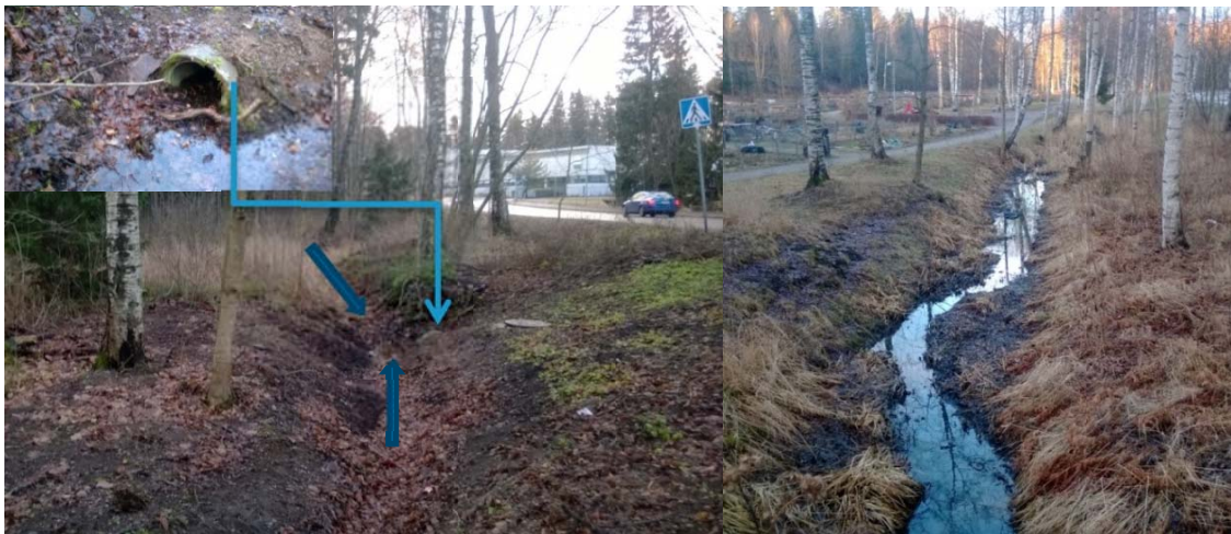
Kuva 41. Alppiruusuipuiston luoteisosan uomaston purkupiste Aino Acktén tien alitse johtavaan rumpuun (vas.) ja tien länsipuolen uoma. Tien alittavaan rumpuun (800B) tulee puiston vesien lisäksi valuntaa 600B hulevesiviemäristä noin 10 hehtaarin alueelta puiston pohjoispuoleiselta asuinalueelta
