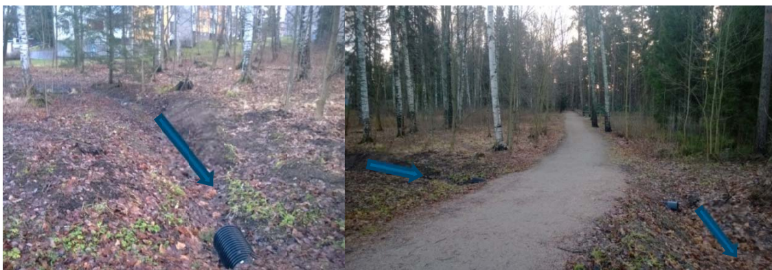
Kuva 42. Hiljattain kaivettu uoma ja ulkoilureitin alitus noin 40 m koilliseen Aino Acktén tien alituksesta. Ulkoilureitin alla kulkee verkostonkartan perusteella 225B hulevesiviemäri itään päin.
