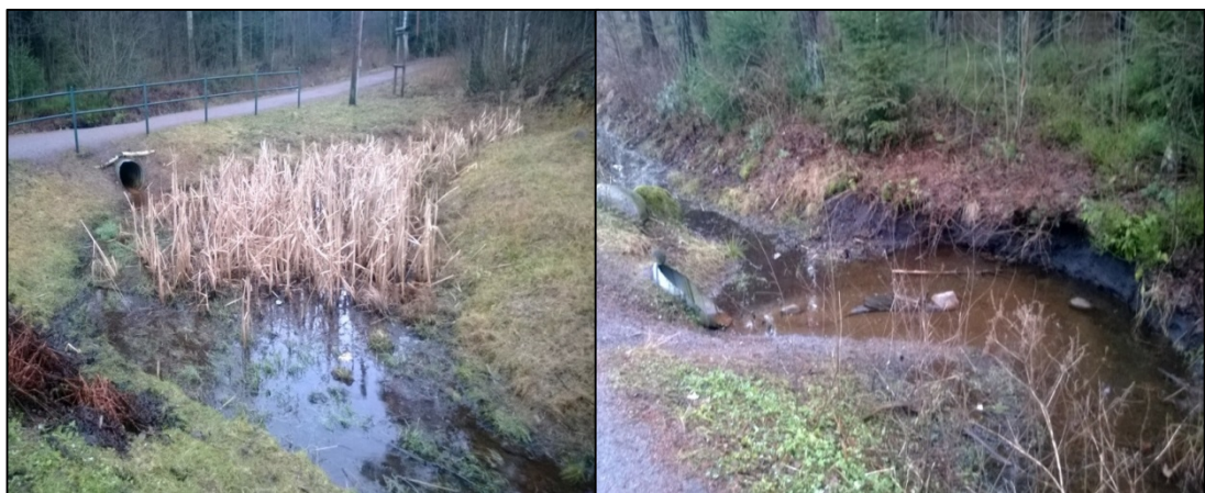
Kuva 46. Uoman laajennus ja rumpu ulkoilureitin ali Ruutipuiston itäosassa. Rummun jälkeen virtaus kovertanut penkkaa.
