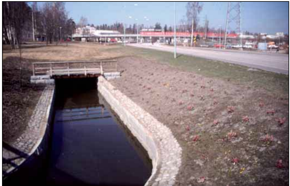
Kuva 43. Mellunkylänpuro Kontulantien ja Länsimäentien alituksen jälkeen 3 .
