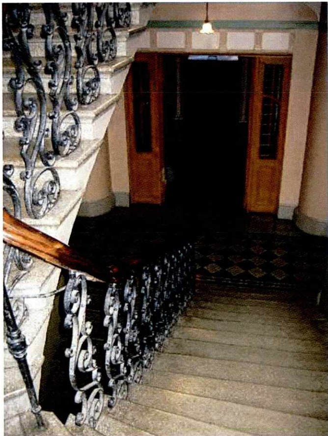
Porrashuone ennen hissien asentamista
