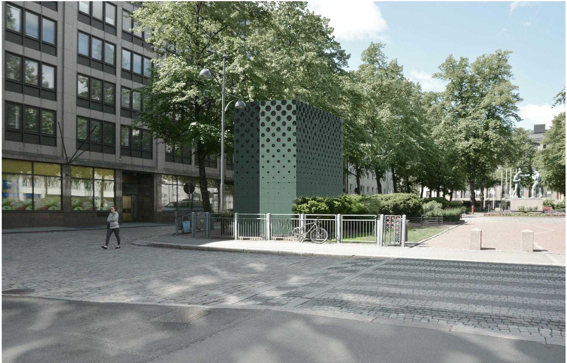
Paasivuorenpuistikon ilmanvaihto- ja savunpoistokuilu
