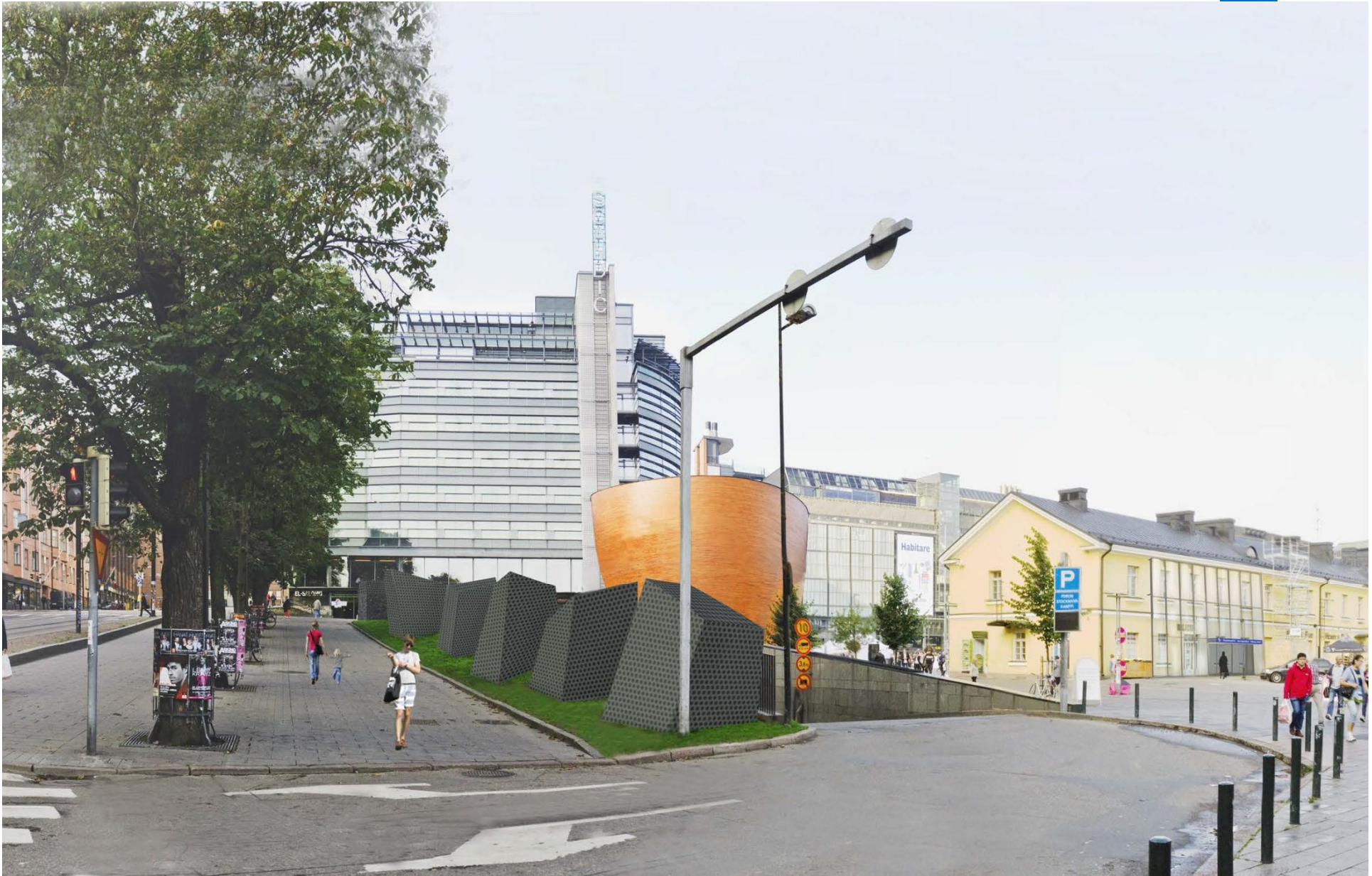
Simonpuistikon ilmanvaihto- ja savunpoistokuilut
