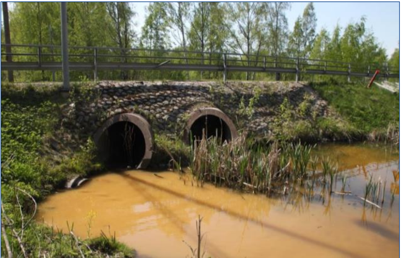
Kuva 10.4.3-1. Otaniementien tierummun sulkeminen (kartassa 1/100a meritulvan mukainen tilanne). Alemmassa kuvassa on tierummun merenpuolinen pääty.
