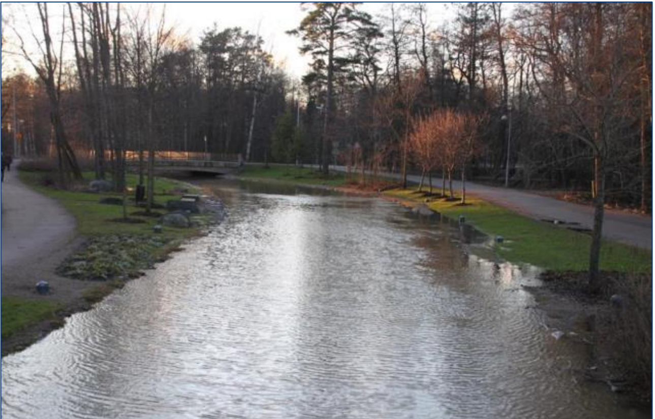
Kuva 6.2-1. Roihuvuoren ja Tammisalön välinen Strömsinkanava tavallisella vedenkorkeudella pvm. 10.6.2007 (ylh.) ja noin N_{2000} + 1,20 m meritulvan aikana pvm. 27.12.2011 (alh.). (Kuva: M. Vähäkäkelä)
