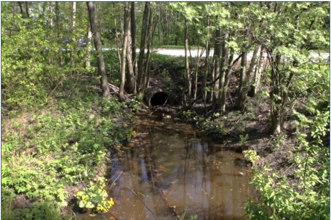
Kuva 10.4.3-3. Hyljelahdentien tierummun sulkeminen (kartassa 1/100a meritulvan mukainen tilanne). Alemmassa kuvassa on yläjuoksun puoleinen tierummun pääty.
