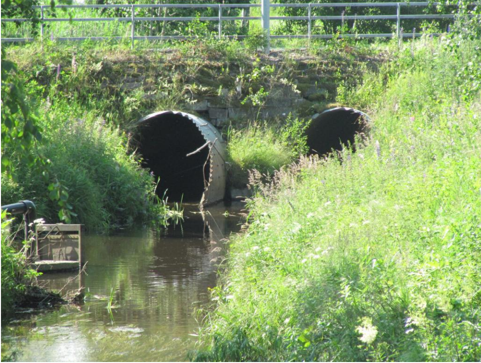
Kuva 9.5. Riihimäen Teollisuuskadun siltarummut. (Kuva Merja Suomalainen 2014)
