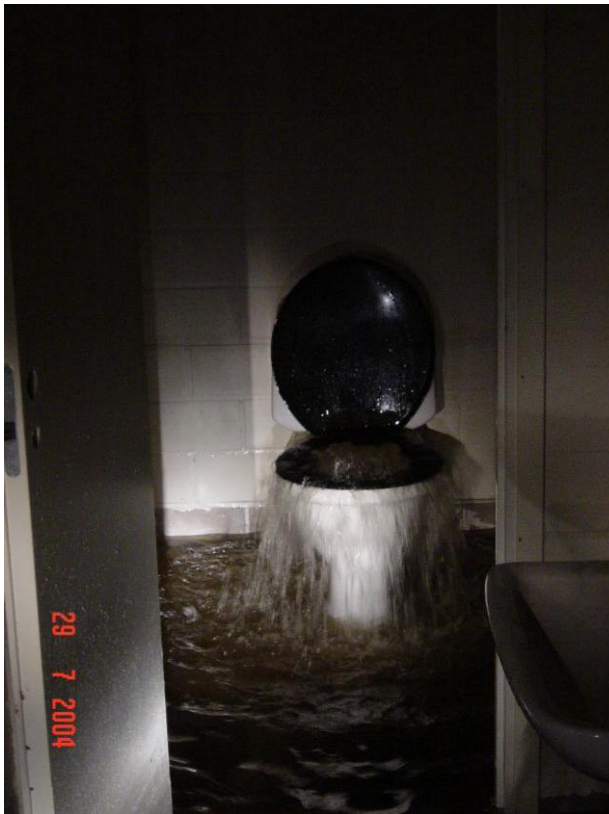
Kuva 10.1. Kellarikerroksen WC-pönttö tulvii Riihimäen tulvassa. (Kuva Kanta-Hämeen pelastuslaitos 2004)
