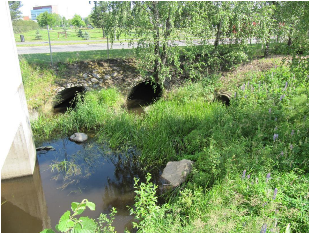
Kuva 10.4. Kulmalan Puistokadun siltarummut. Vuoden 2004 tulvassa vettä jouduttiin pumppaamaan myös tien yli. (Kuva Merja Suomalainen 2014)
