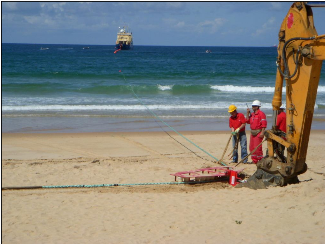
Kuva 10. Raskas kaivuri ankkuroimassa rullakaarta.
