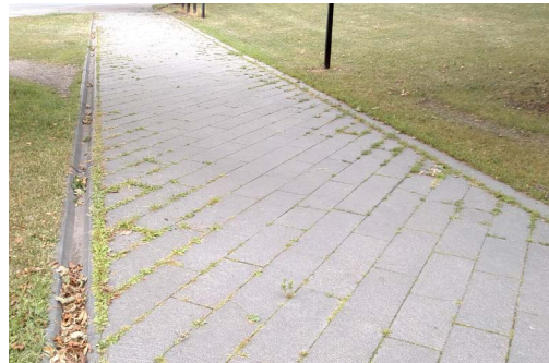
Esimerkki yhtenäisen suunnan käytöstä sommitelmassa; graniittikiveyksen ladontasuunta noudattaa rakennuksen koordinaatistoa.
