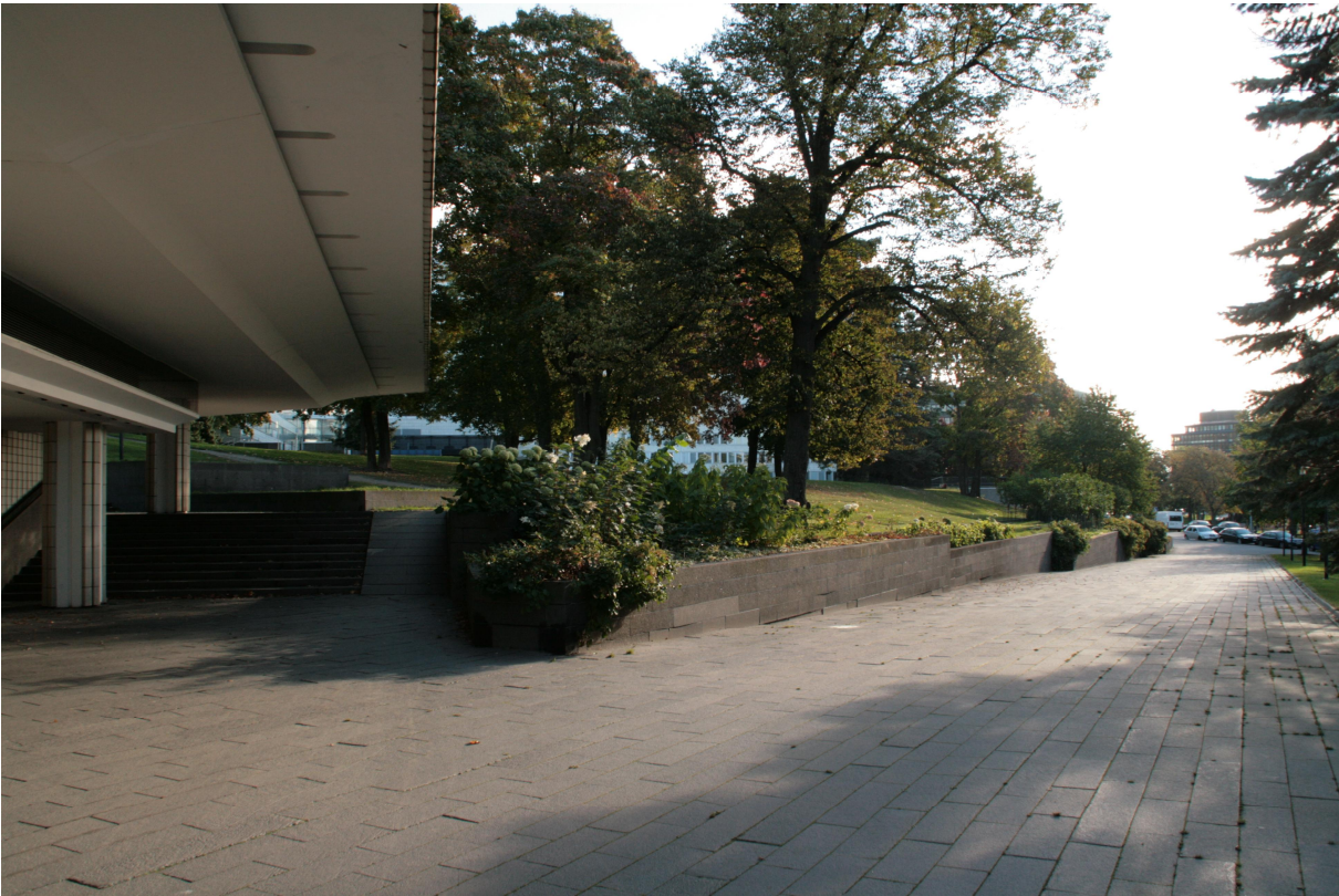
Itäpäädyn ulkoporras ja tukimuuri
