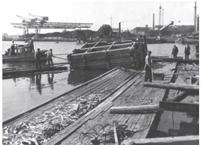
Sörnäisten satama, silta-arkun työmaa 1955
