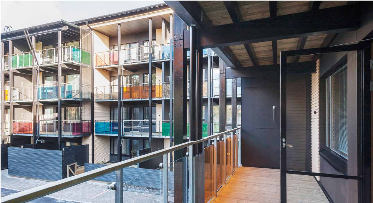
Att:n rakennuttama asumisoikeuskohde Omenapuisto Vuosaarella. Kuva: Att.
