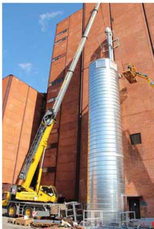
Kuva 11-8. Esimerkkikuva pellettisäiliön pystytyksestä (kuva: Helsingin Energia)
