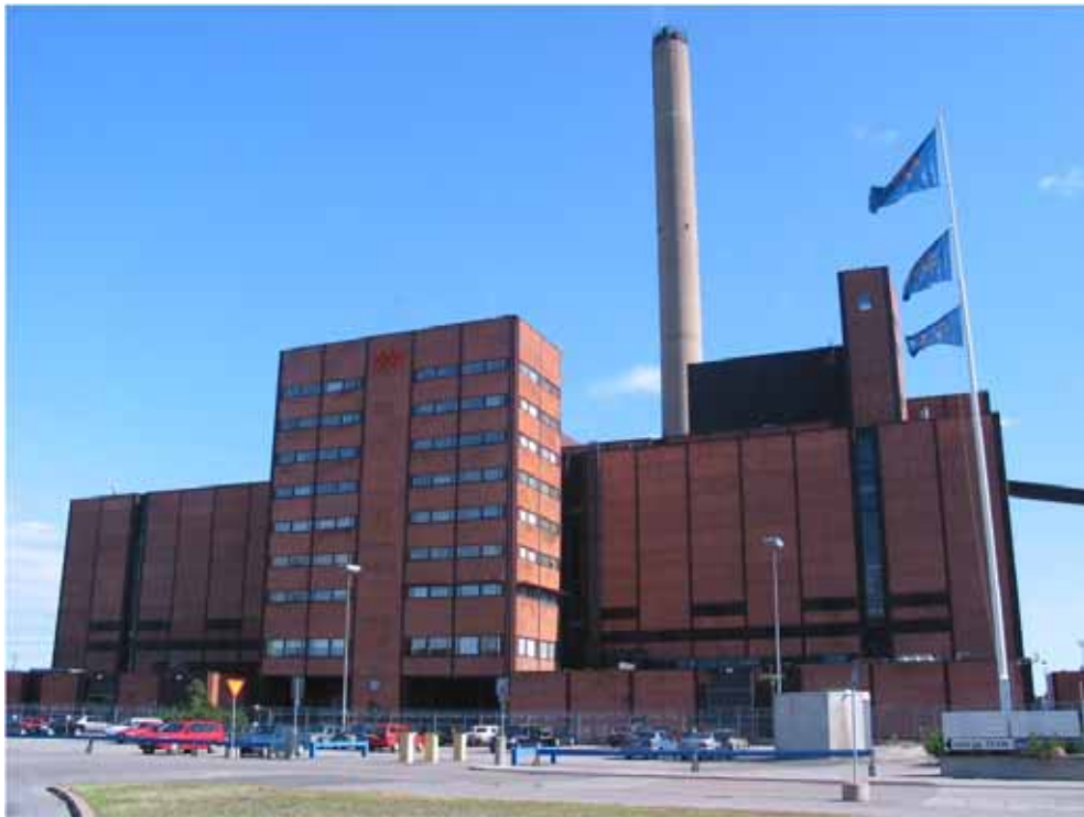
Kuva 2-2. Hanasaaren B- voimalaitos (kuva: Helsingin Energia).
