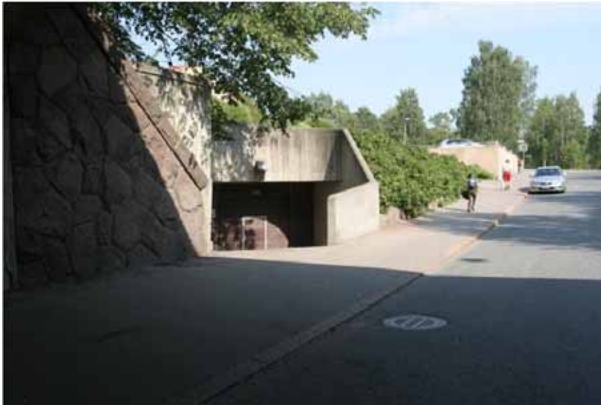
Kuva 11-5. Esimerkkikuva jo toteutetusta ajotunnelista (kuva: Helsingin Energia).
