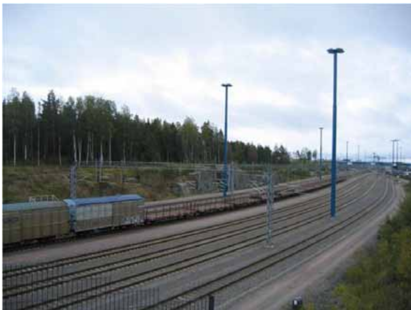
Kuva 11-7. Kuva rautatien ylittävältä sillalta kohti kivihiilen käyttövarasto B:n sijoituspaikkaa.
