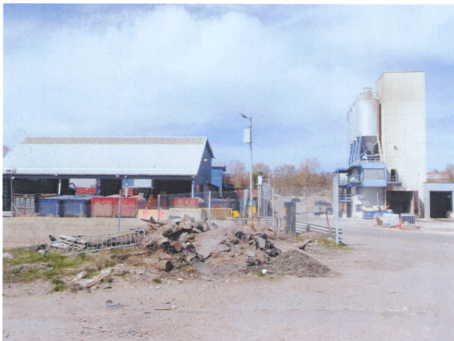
Kuva 9. Kentän länsipuolella olevaa teollisuusaluetta (mm. jätteenkäsittelyä ja betoniasema). Lahdenväylä sijaitsee taustalla näkyvien puiden takana.
