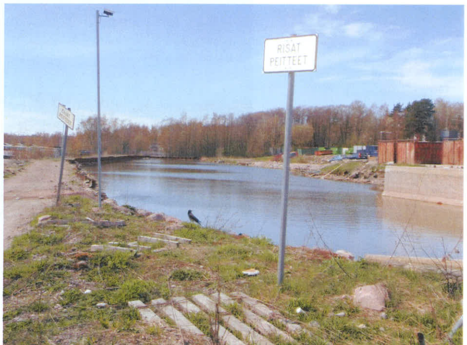
Kuva 8. Lumensulatusallas, johon kentän vedet pumpataan hiekan- ja öljynerotuksen jälkeen.
