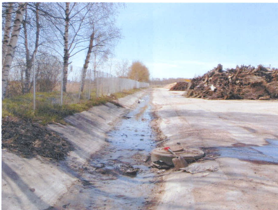
Kuva 4. Käsittelykentän itäreunalla oleva pintavesien keruu ja kuvan etualalla vesien pumppauskaivo. Luonnonsuojelualue aidan toisella puolella. Kuva otettu kohti lounasta.
