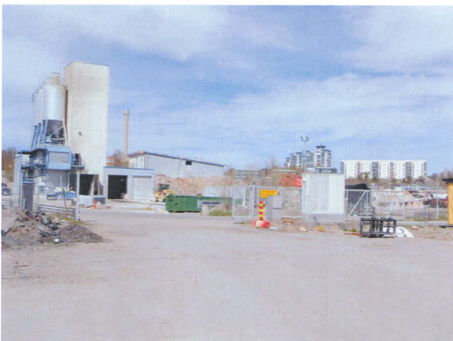
Kuva 10. Lähimmät asuinkerrostalot sijaitsevat Lahdenväylän toisella puolella, käsittelykentästä noin 350 metriä pohjoiseen.
