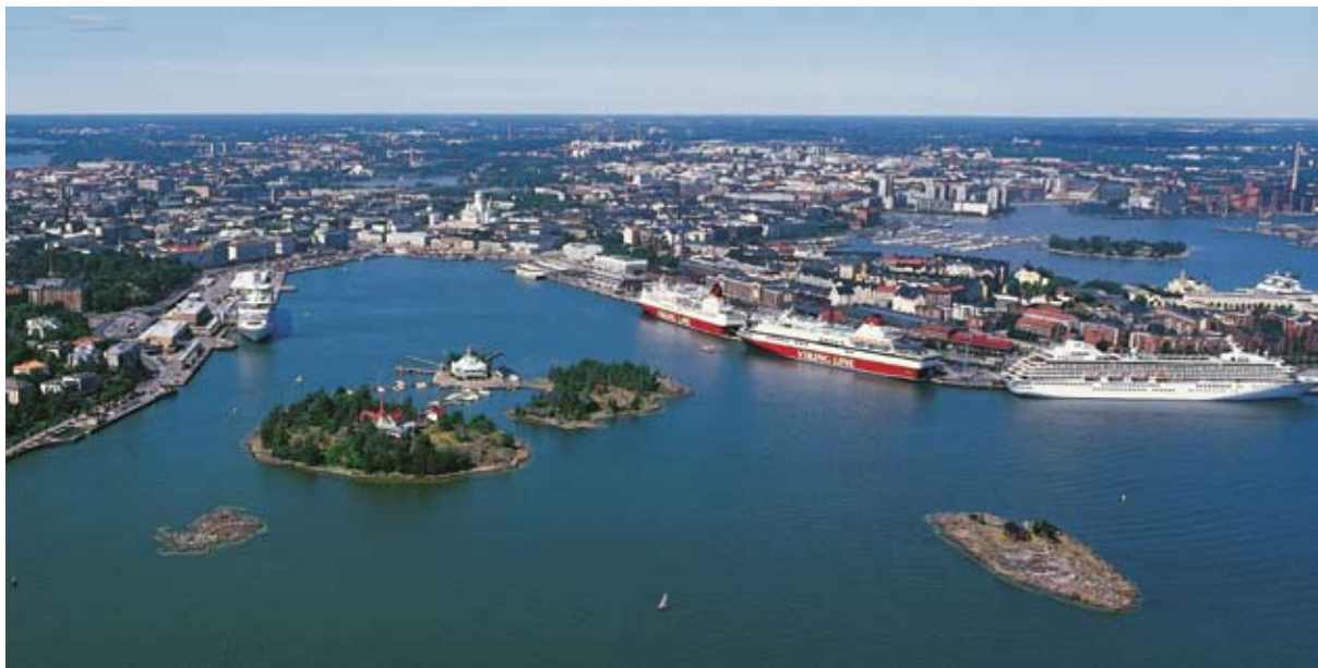
Kaupungit ovat mukana uudessa vuoden 2008 alussa voimaan tulevassa kuntien energiatehokkuussopimuksessa. Kuva: Hannu Vallas / Lentokuva Vallas Oy
