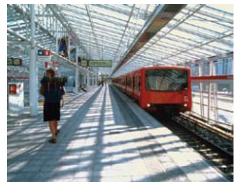
Vuosaaren metroasema. Kuva: HKL
