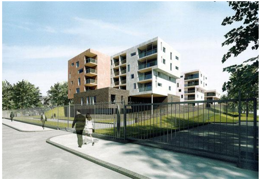
Havainnekuva rakenteilla olevasta hankkeesta (Helin & Co Arkkitehdit)
