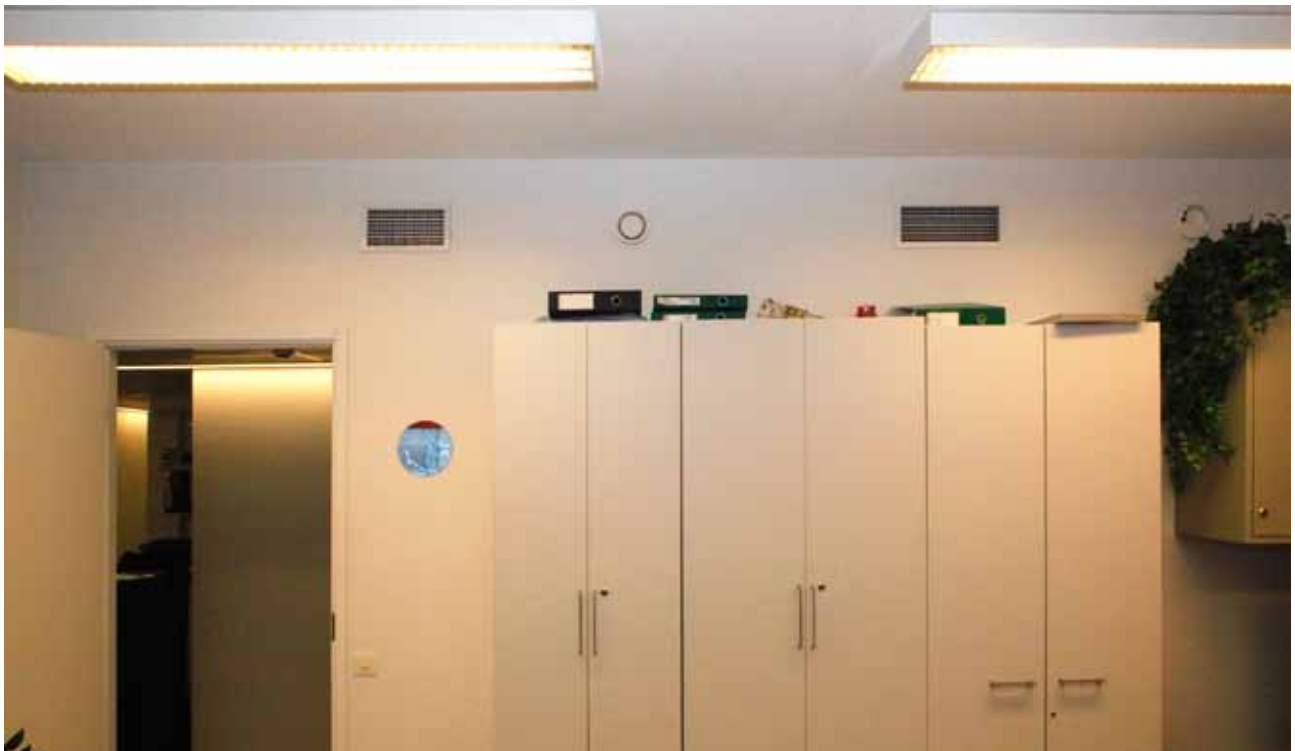
Ilmastointiventtiilit käytävän vastaisessa seinissä. Ilmastointiputket on sijoitettu käytävän päälle.
