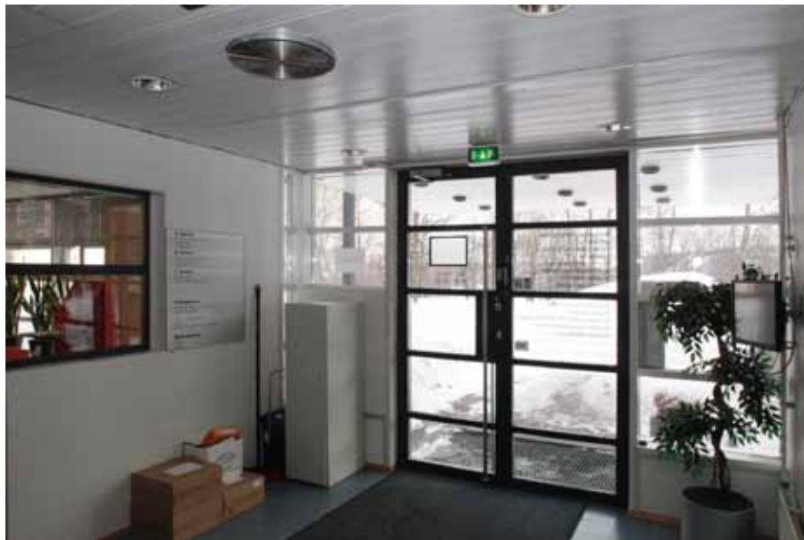
Aula on rakennettu 1980-luvun lopulla. Sieltä on käynti kirjastoon ja pääportaaseen. Kulmahuoneeseen, joka muutettiin 1980-luvulla toimistoksi, on sittemmin sisustettu info-piste (2000-l). Aulan katto on alaslaskettu metallikasettikatto, johon on upotettu valaisimia. Lattiasa on siniharmaa klinkkeri.
