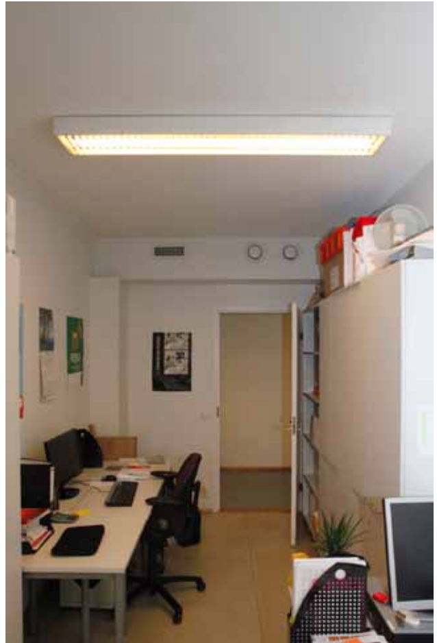
Ilmastointiputken vaakavet on sijoitettu toimistohuoneiden yläkulmaan pihan puoleisissa huoneissa.
