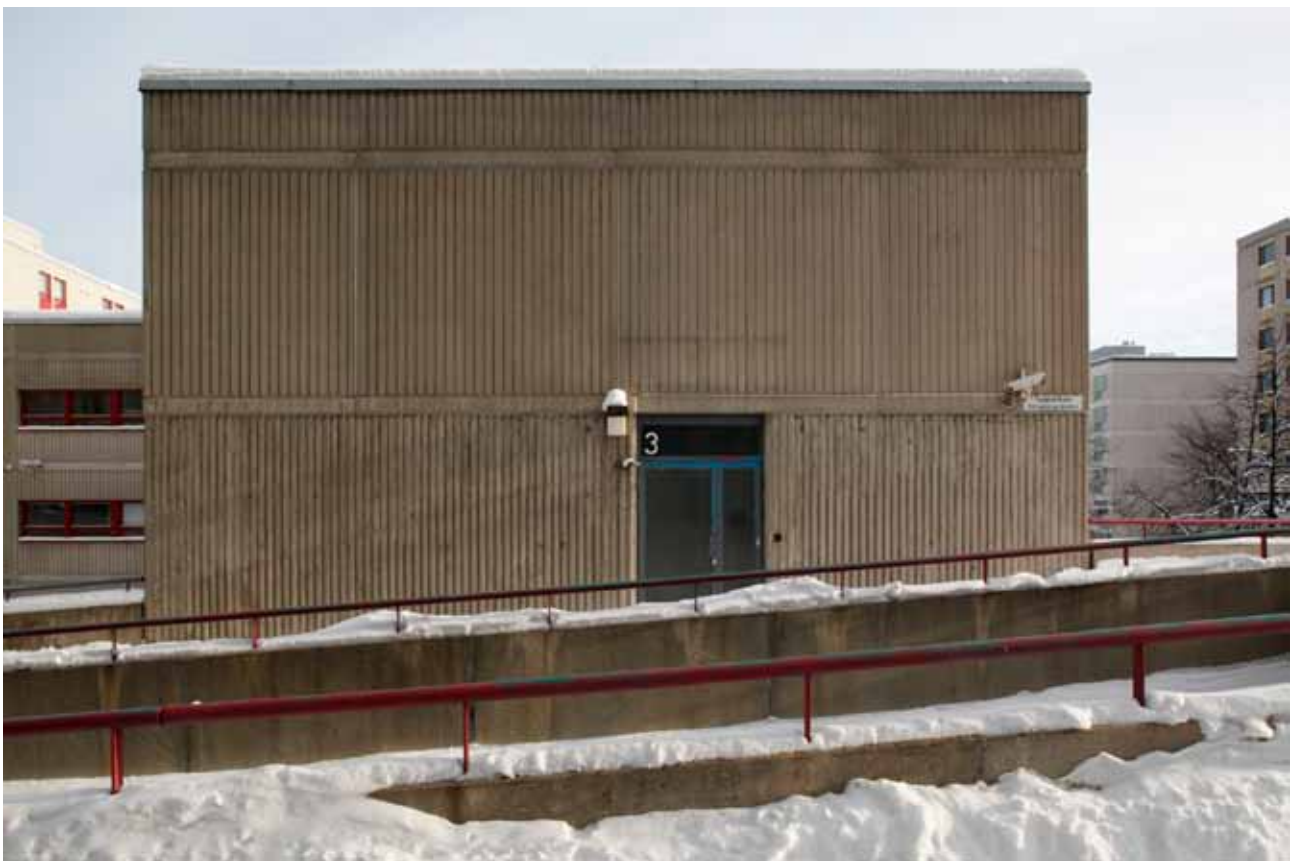
Julkisivuote länteen. Jalankulkutasolta on sisäänkäynti toimiston toiseen kerrokseen, missä on alunperin sijainnut pääaula. Julkisivun alimman kerroksen elementin uritus on ekspressiivisempi kuin ylemmässä kerroksessa.
