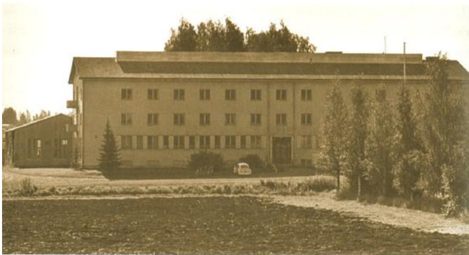
Tn. 1950-luvulla rakennuksen pohjoispuolelta otetussa kuvassa näkyy rakennuksen pihapiiriin kuulunut varastorakennus. (kuva lähteessä Jalas 2002, s. 56)
