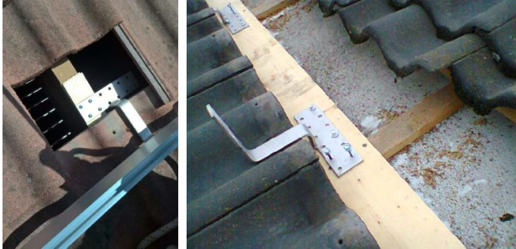
Kiinnitysesimerkki tiilikattoon. [Kuva Green Energy Finland]
