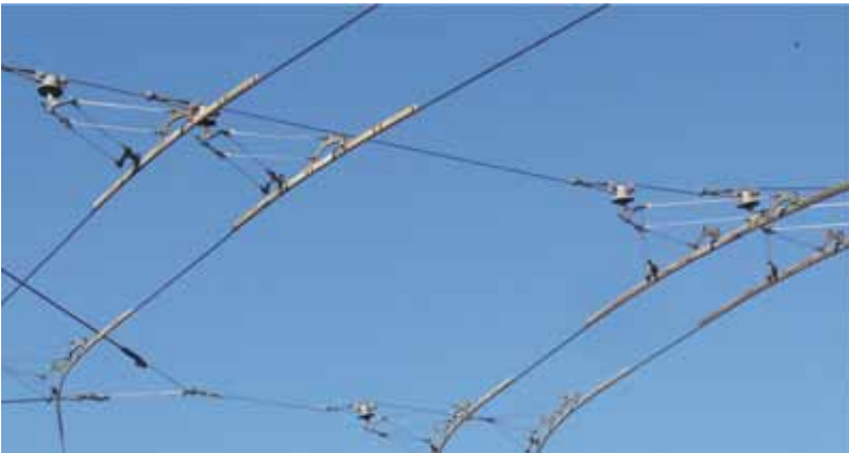
Kuva 9. Ajojohtoja (R. Mättö 2008)
