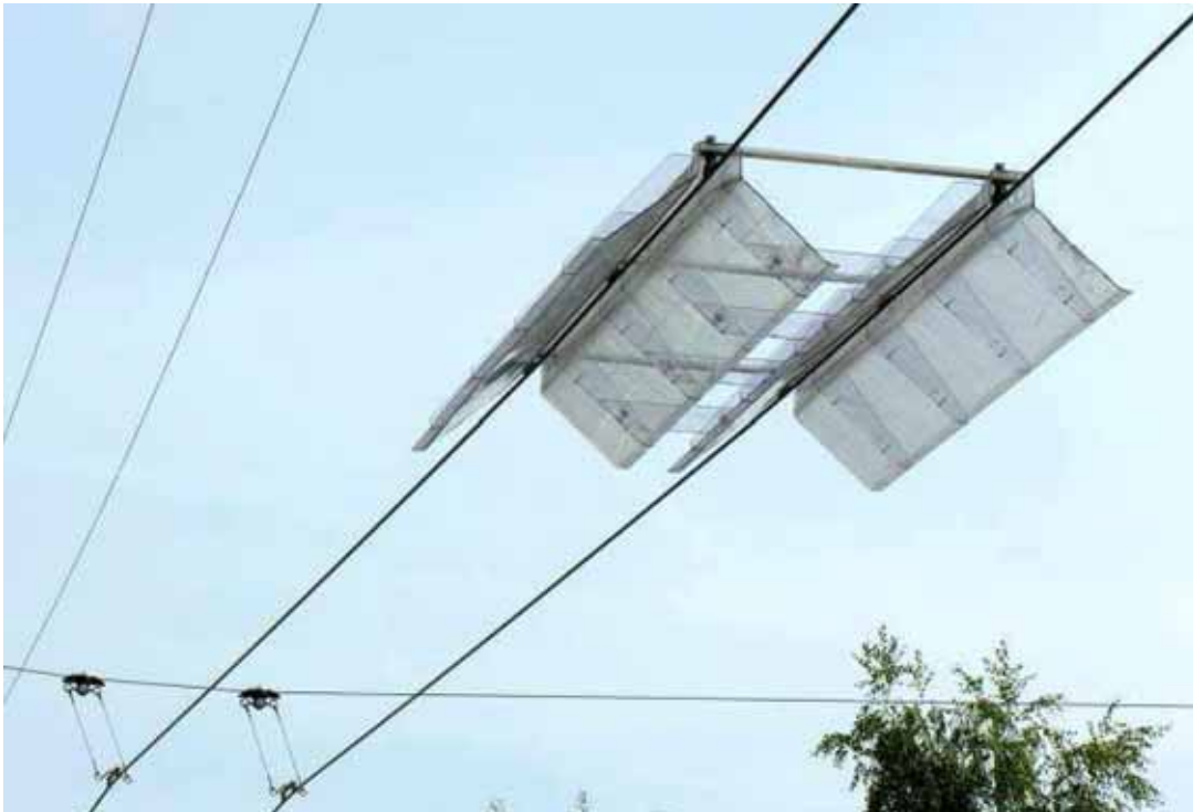
Kuva 16. Ohjaussuppilo ajolangoissa (kuva R. Mättö)
