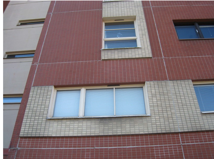
JULKISIVUA ON JÄSENNELTY VAALEAMMILLA OSILLA
