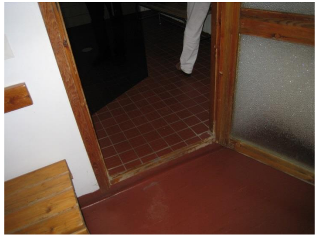
Saunaosaston pesuhuoneen ja pukuhuoneen tasoero
