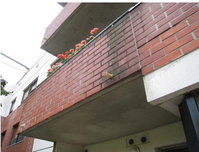
Julkisivuvaurioita mm. rikkinäiset vedenheittäjät kastelleet julkisivua ja vaurioituneita tiiliä
