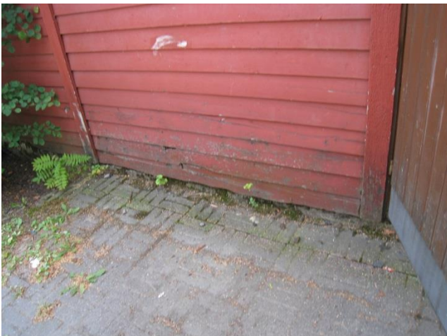
Piharakennuksen lahovaurioituneita seinän alaosia
