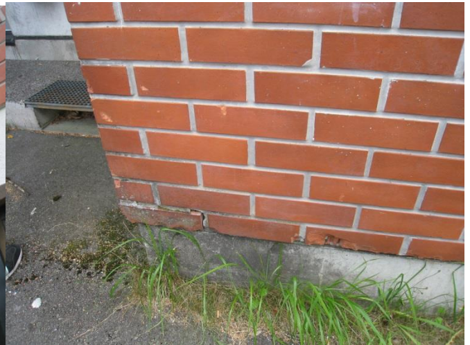
Julkisivuvaurioita mm. rikkinäiset vedenheittäjät kastelleet julkisivua ja vaurioituneita tiiliä
