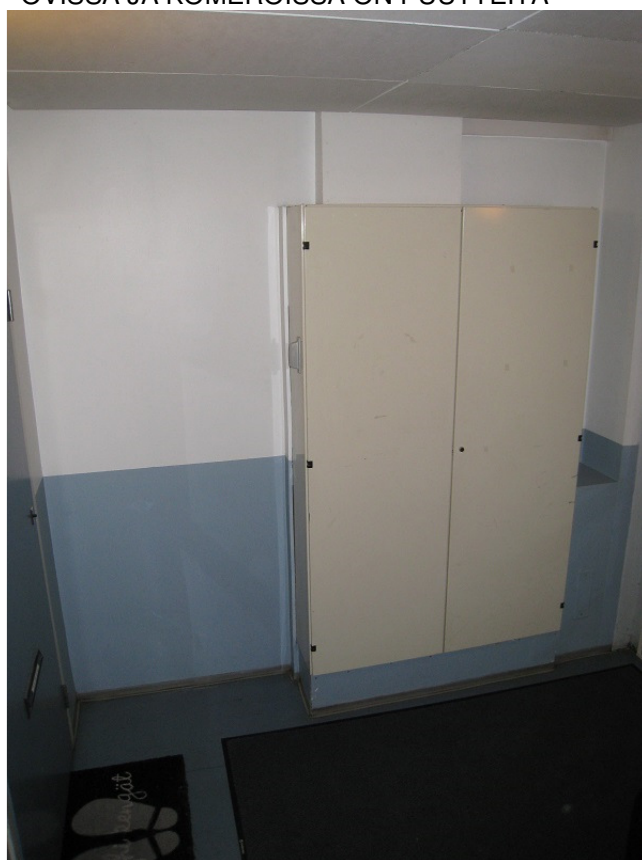
PORRASHUONEEN OSASTOIMATON SÄHKÖKESKUS
