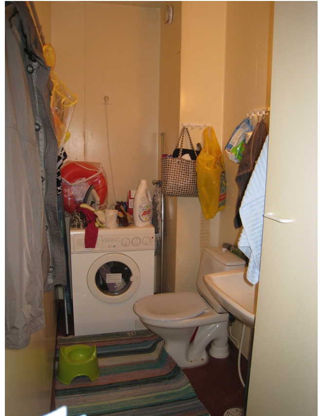
KYLPYHUONEET JA WC:T OVAT ALKUPERÄISIÄ
