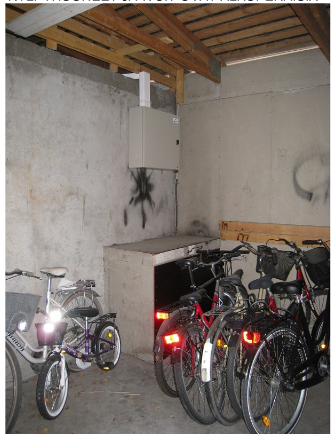
VARASTON PAIKALLE RAKENNETAAN LJH
