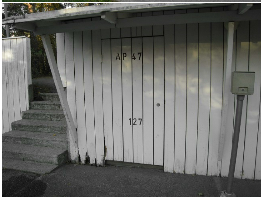
VARASTOIHIN LISÄTÄÄN SOKKELIT
