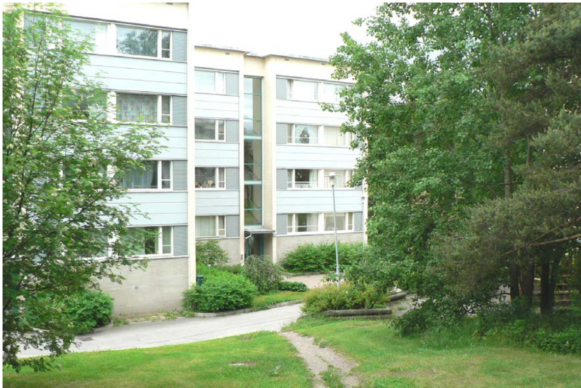
Talo 8 a sisäänkäyntien puoleinen julkisivu
