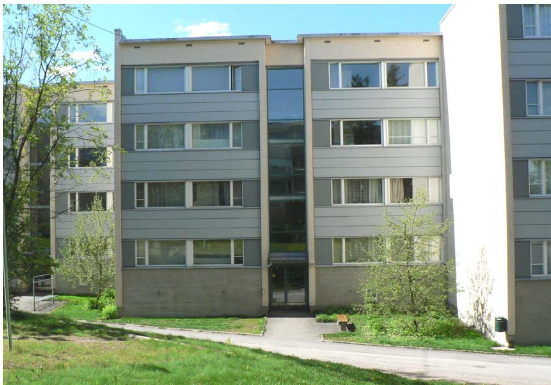
Talo 8 b, nykyinen sisäänkäyntien puoleinen julkisivu B-portaan kohdalta.
