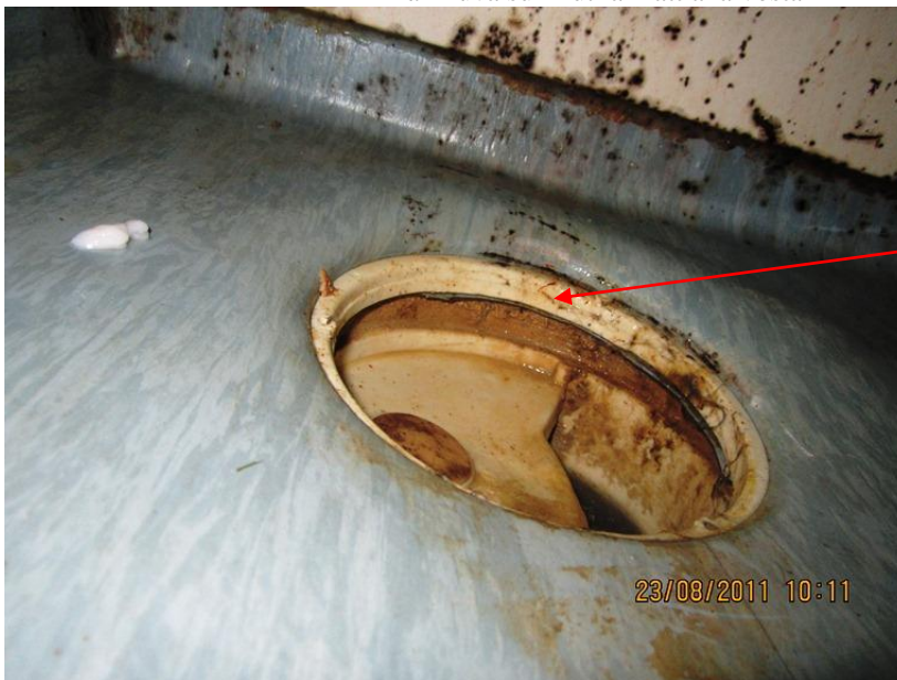
Lähikuva suihkutilan lattiakaivosta
