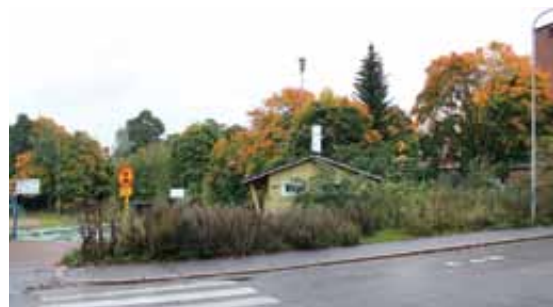
Kuvat 37-41 | Kuvia vaurioista ja arvon heikentävistä tekijöistä. NA.
