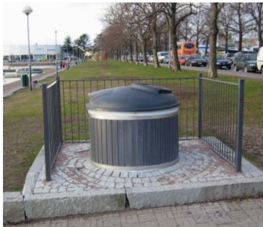
Kuva 8. Kompassin laiturin läheisyydessä sijaitseva jäteastia ja sekajätteen syväkeräyssäiliö.
