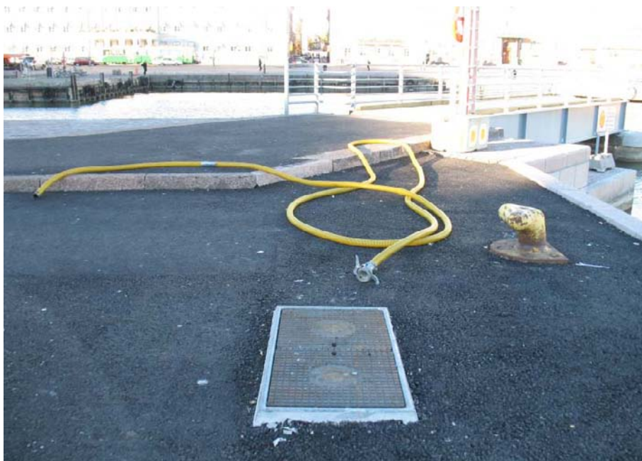
Kuva 26. Lyypekinlaituri, joka on kunnostettu v. 2010. Kunnostuksessa laiturille asennettiin mm. vesi-, sähkö- ja septitankin tyhjennyspisteitä.
