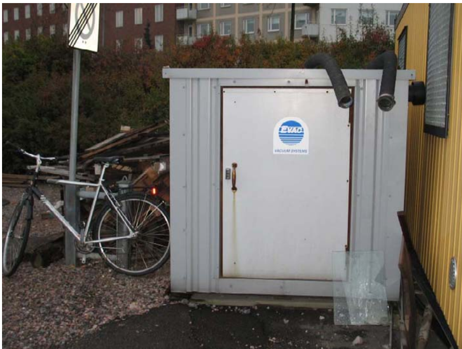
Kuva 19. Septitankin ja pilssiveden imutyhjennyslait- teen pumppaamo.
