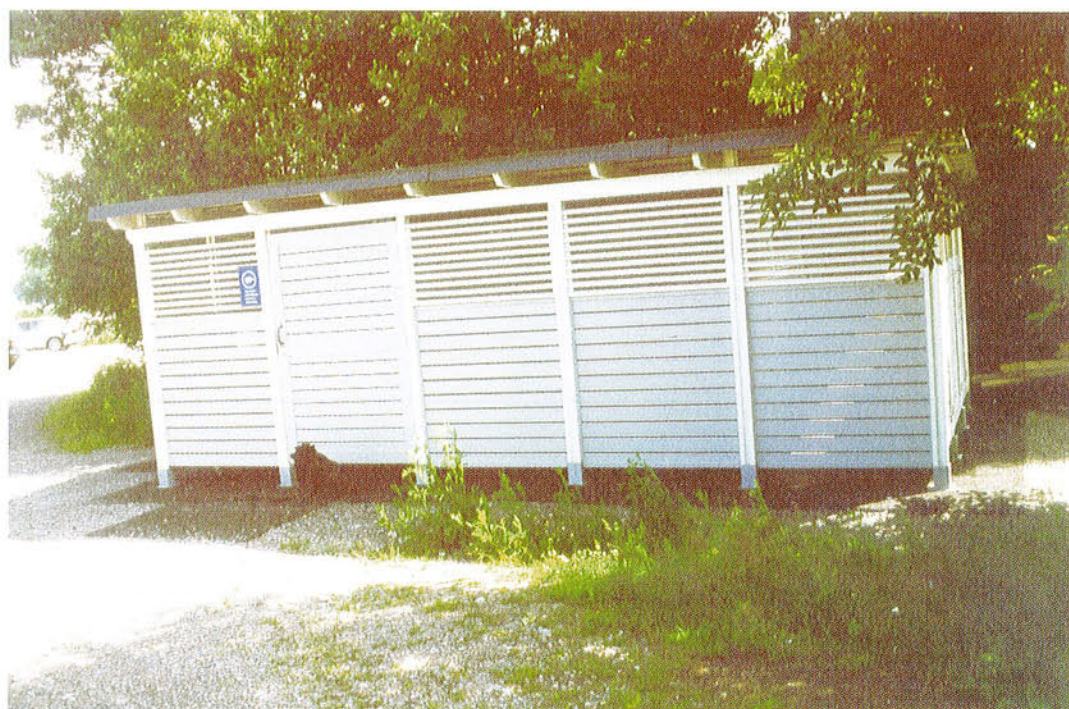
Kuva 18. Useissa venesatamissa ja talvisäilytysalueilla on hyvätasoiset jätekatokset, joissa on omat osastonsa myös ongelmajätteille. Lemislahden venesatama ja talvisäilytysalue. Kuva H. Airola.
