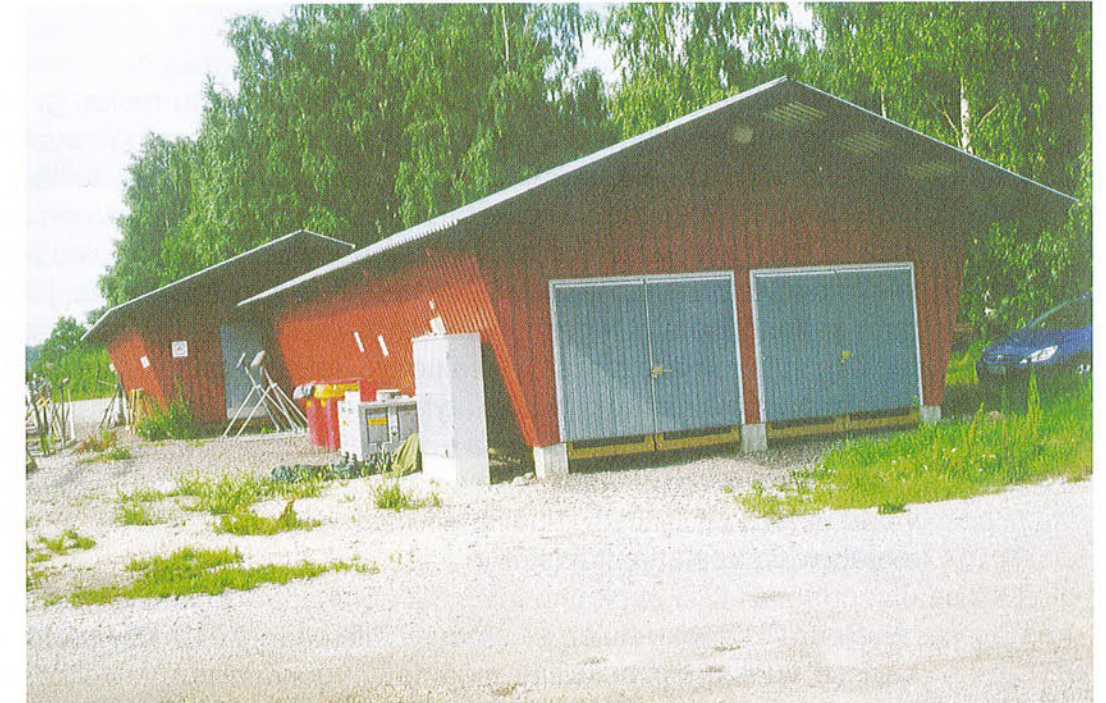
Kuva 17. Talvisäilytysalueiden yleisimpiä rakennuksia ovat erilaiset varastot sekä masto-vajat ja –katokset. Koivusaaren itäinen talvisäilytysalue. Kuva H. Airola.
