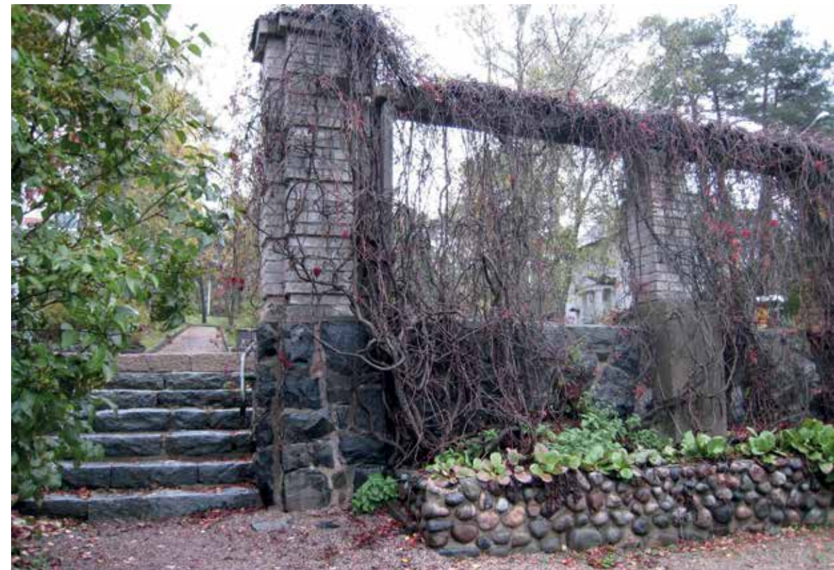
Kuva 50 | Ribbinginhovin puistikko päättyy pohjoisessa korkeaan tukimuriin ja sen päällä sijaitsevaan pergolatyypiseen seinämään. Sen molemmin puolin olevat portaitot johtavat Kulosaarentielle. Kuva TP.
