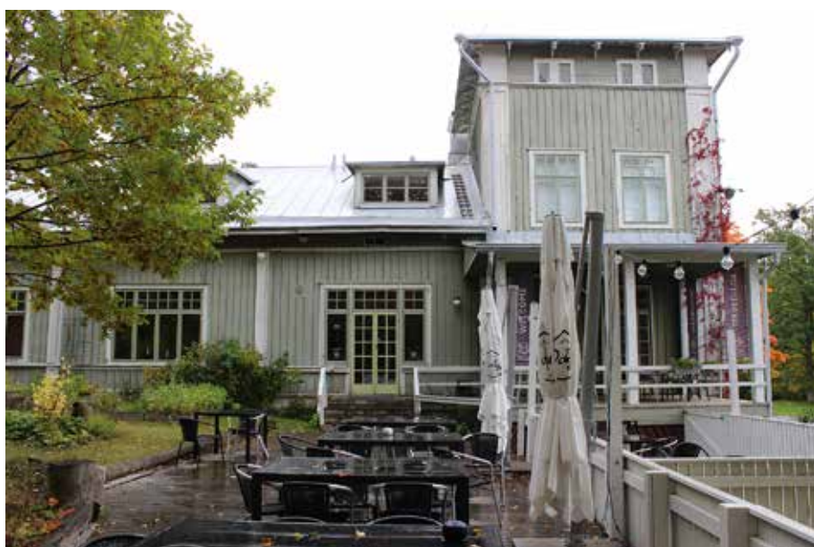
Kuva 62. Rastilan päärakennuksen julkisivu länteen vuonna 2019. Kuva LV
