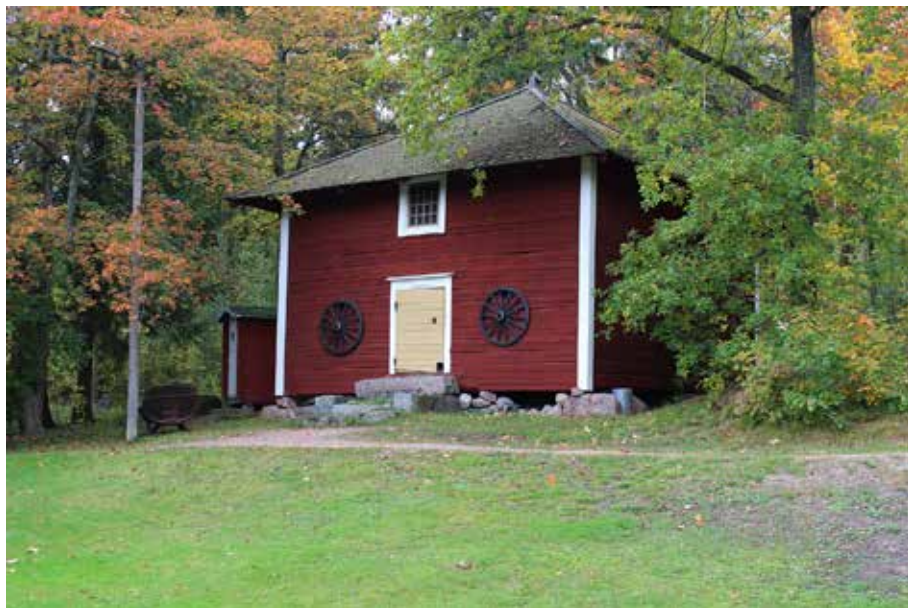
Kuva 78. Tallipihalla sijainnut viljamakasiini on rakennettu vuonna 1812. Nykyiselle paikalle päärakennuksen länsipuolelle rakennus on siirretty vuonna 1995. Kuva LV
