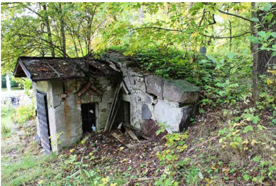
Kuva 77. Rastilan päärakennuksen luoteiskulman tuntumassa sijaitseva maakellari. Kuva LV
