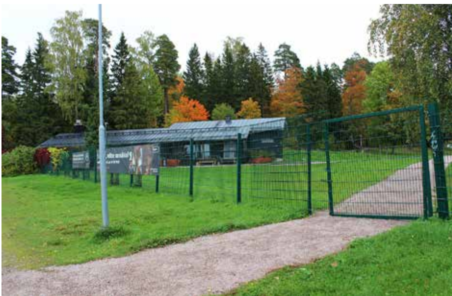
Kuva 102. Kartanon ja uimarannan väliin pystytetty aita, siihen kiinnitettyine mainoksineen, sulkee kartanon ja Vartiokylänlahden avoimen maisematilan eikä sovi kartanoympäristöön. Kuvassa näkyvä käytävä on rakennettu vuonna 2018. Uimarannan kohdalla aidassa on kaksi suljettua huoltoporttia ja käyntiportti, josta kartanolle kuljetaan saunarakennuksen takaa. Kuva LV.
