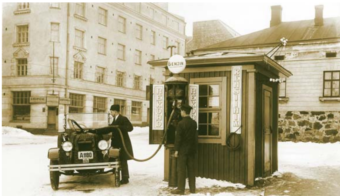
Kaupungin ensimmäinen bensiiniasema avattiin Hietalahdentorilla vuonna 1921.
