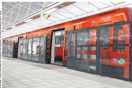
Automaattimetroon siirtyminen tuo asemille laituriovet. Kuva Vuosaaren metroasemalta.
