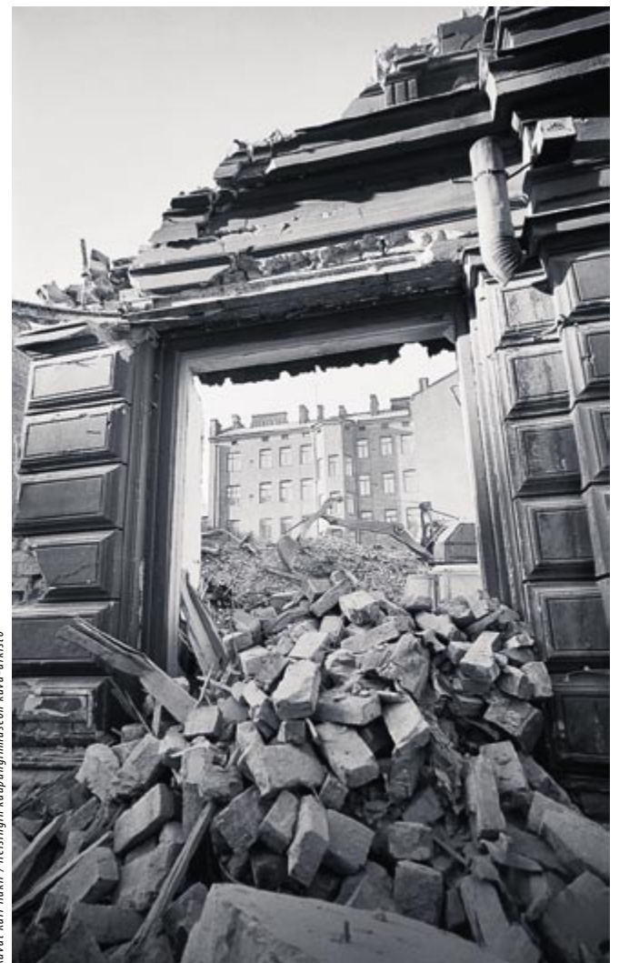
Kivi kiveltä hajotettava vanha talo sai väistyä uuden rakennuksen tieltä vuonna 1971. Purkutyömaana on Fabianinkatu 8.
