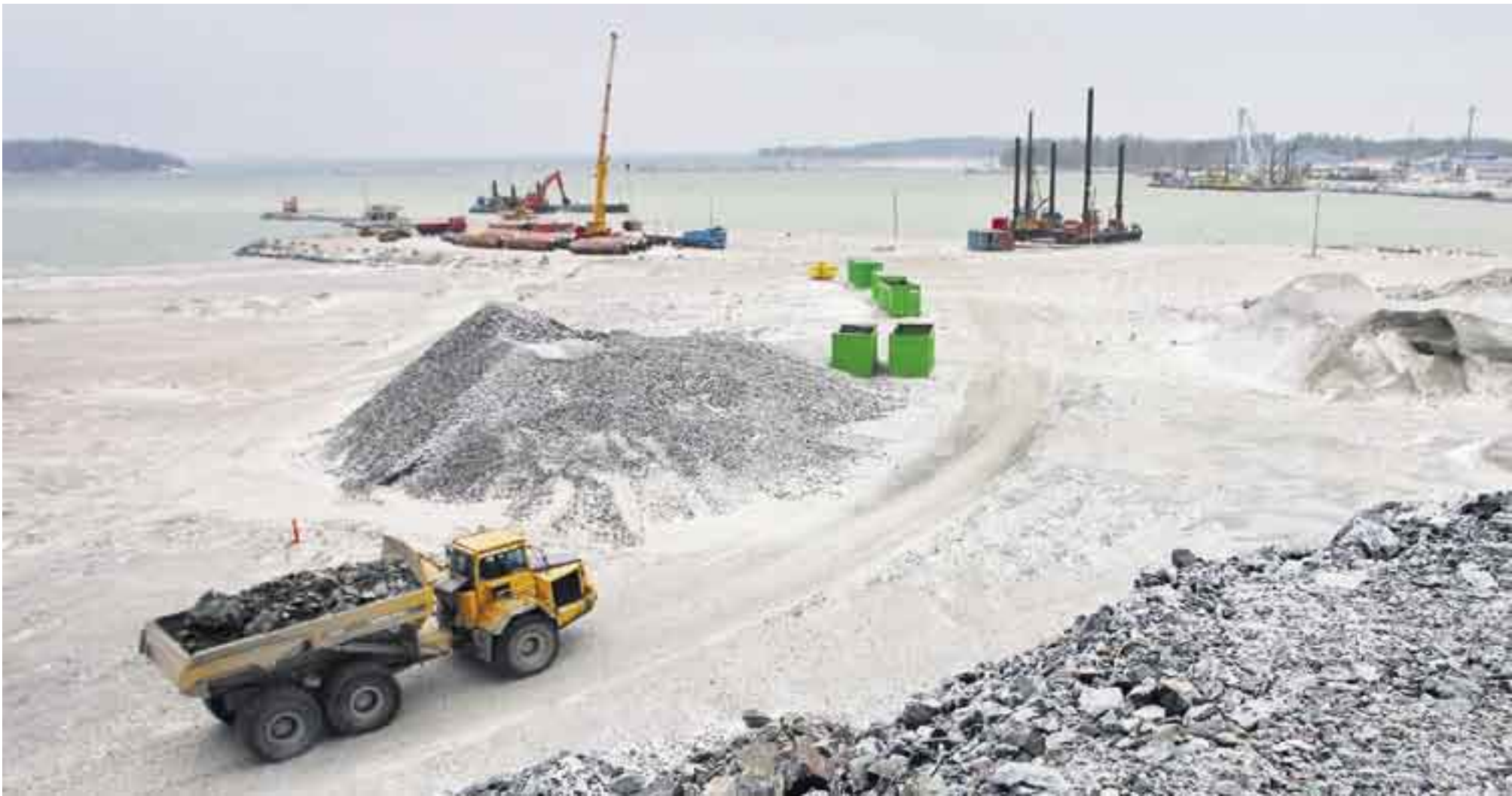
Syksyllä 2008 saapuvat ensimmäiset laivat. Parhaillaan rakennetaan teitä ja laitureita, täytetään satama-aluetta merihiekalla ja kivimurskalla sekä viimeistellään ruopattua meriväylää.
