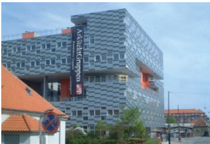
Monipuoliset yhteistilat ja -terassit kiertävät rakennusta. Opiskelija-asuntola Örestadenissa Kööpenhaminassa. AART A/S, 2006.
