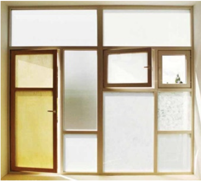
Tutkielma muuntojoustavasta julkisivusta. Julkisivu koostuu eritoimintaisista osista, joita on mahdollista täydentää ja muunnella rakennuksen elinkaaren aikana 1 . Arkkitehdit M3 Oy. Kuva Heli Sorjonen.
