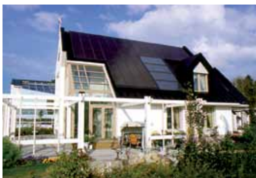
Kuva 8. Pietarsaaren IEA5-Aurinkotalo ja sen rakenneratkaisut.
