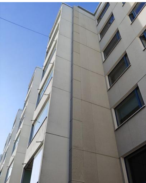
Värmeåtervinningsrör i Rödbergen. En motsvarande placering förutsätter inget lov från byggnadstillsynen.
