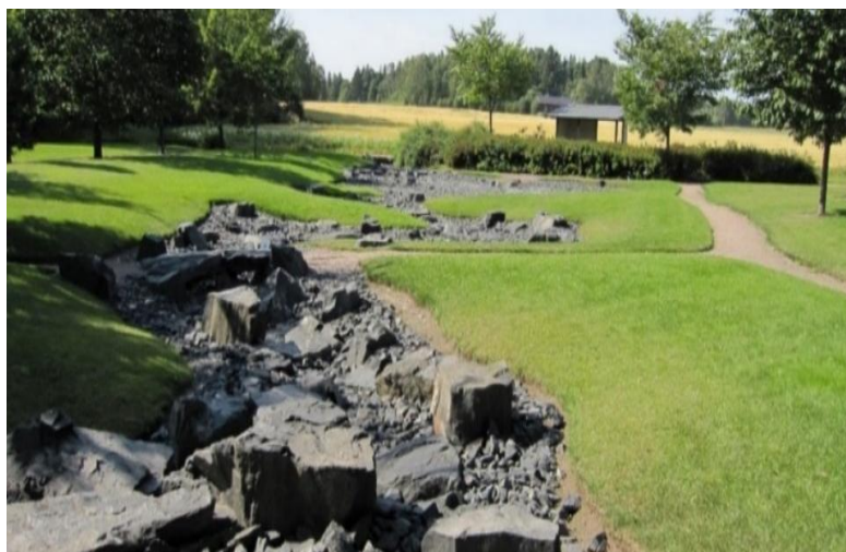
Bild 1. Konstruktion som fördröjer dagvattnet i Eko-Vik.
