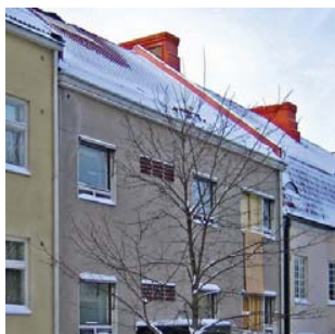
palomuri nousee kattopinnan yläpuolelle, räystäskorot vaihtelevat, Hollantilaisentie, Munkkiniemi
