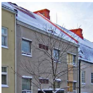
palomuurit nousee kattopinnan yläpuolelle, räystäskorot vaihtelevat, Hollantilaisentie, Munkkiniemi
