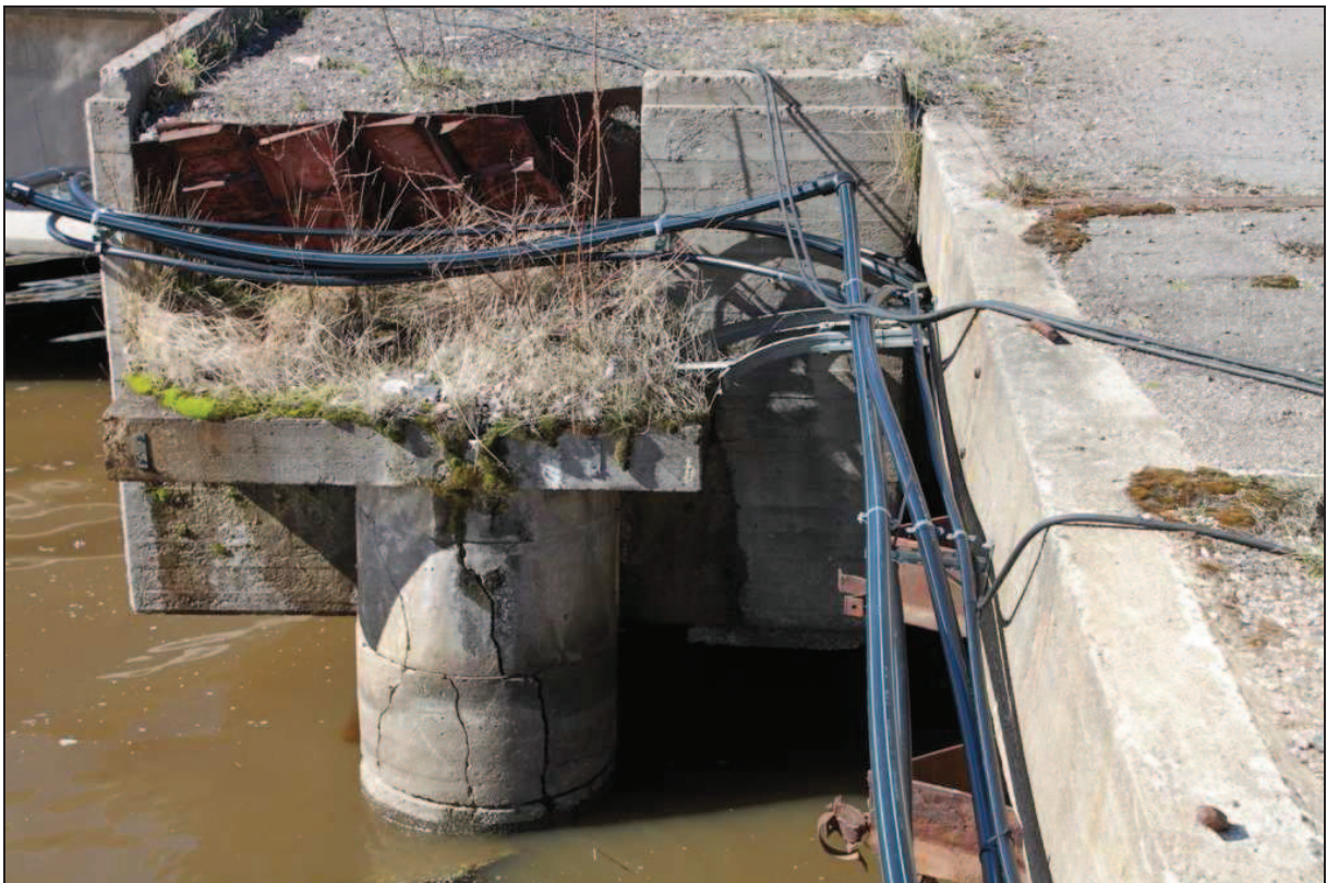
Kuva 6. Laiturin keskiosan sillakkeen betonivaurioita
