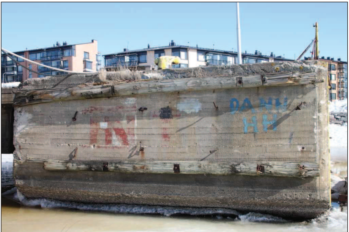
Kuva 20. Laiturin eteläpäädyn puusuojaite.
