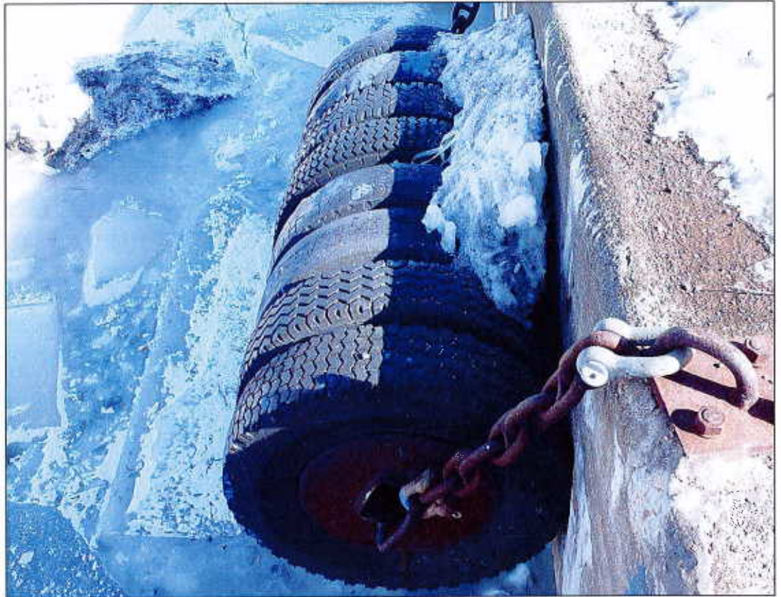
Kuva 21. Rengasnipuista toteutettu jäänmurtajalaiturin suojalaite.(kuva: Asuntolaivurit ry)
