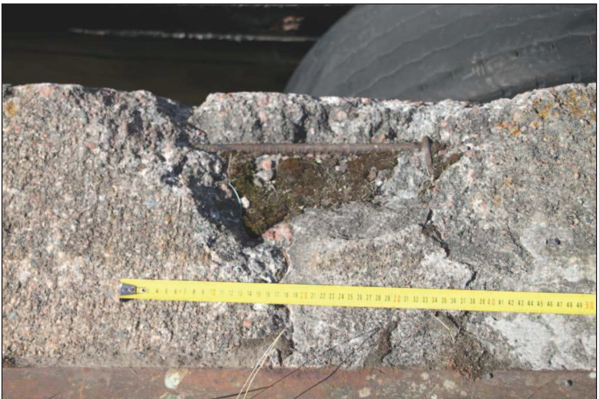
Kuva 12. Laiturin kannen betonivaurioita
