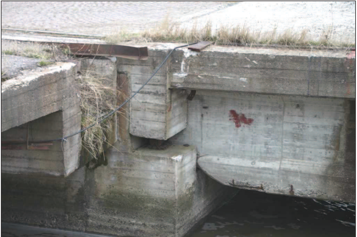
Kuva 17. Betonivaurioita ja kasvillisuutta laiturin kannella
