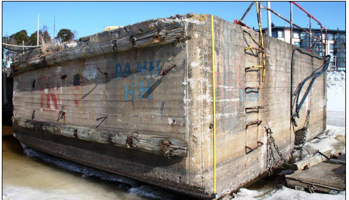
Kuva 13. Puusuojalaitteen sekä teräsrakenteiden kunnostustarpeita laiturin eteläosassa.
