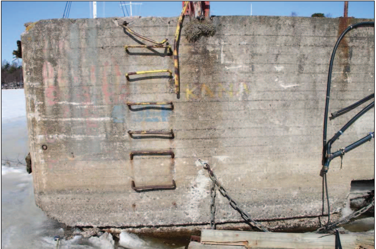
Kuva 21. Laiturin eteläpääty ja siinä olevat pelastustikkaat.
