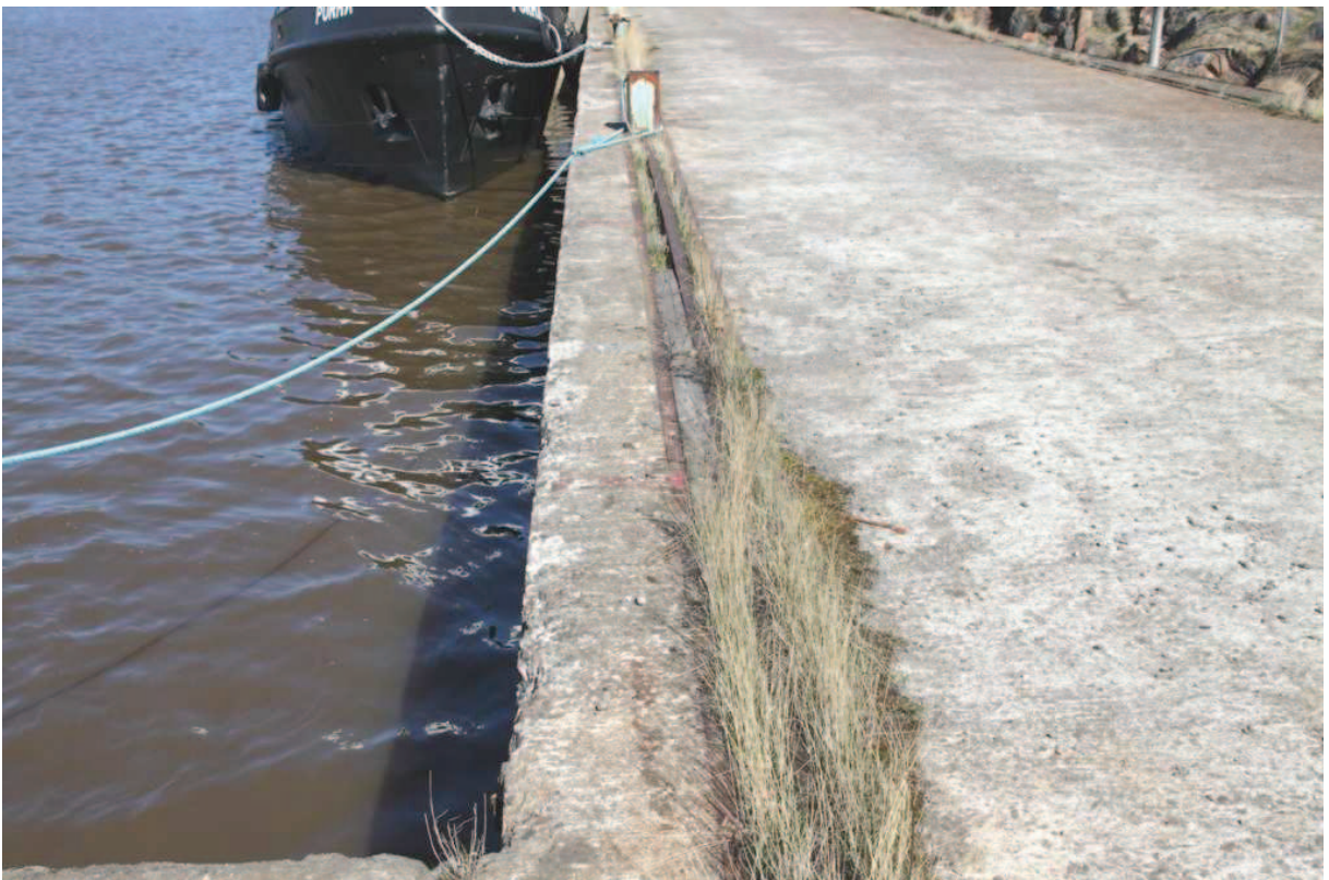
Kuva 16. Kasvillisuutta laiturin kannella. Laiturilla olevat kiskot ovat täyttyneet ja kasvavat heinää ym. kasvillisuutta.
