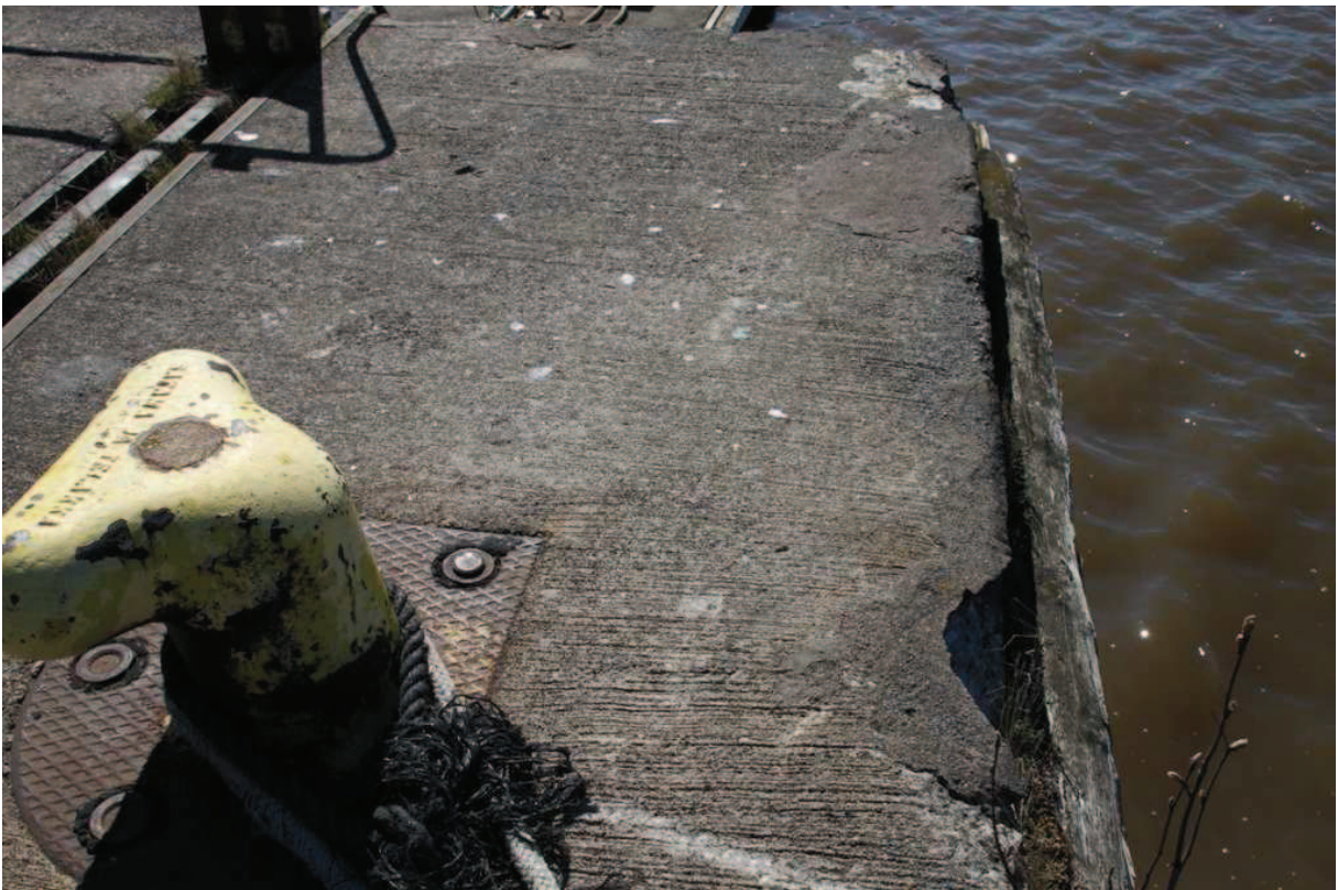
Kuva 8. Laiturin kannen betonivaurioita eteläpuolen arkun kohdalla.
