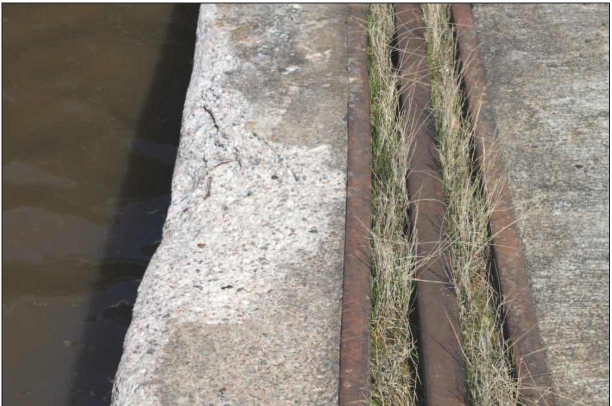
Kuva 14. Laiturin kannen betonivaurioita
