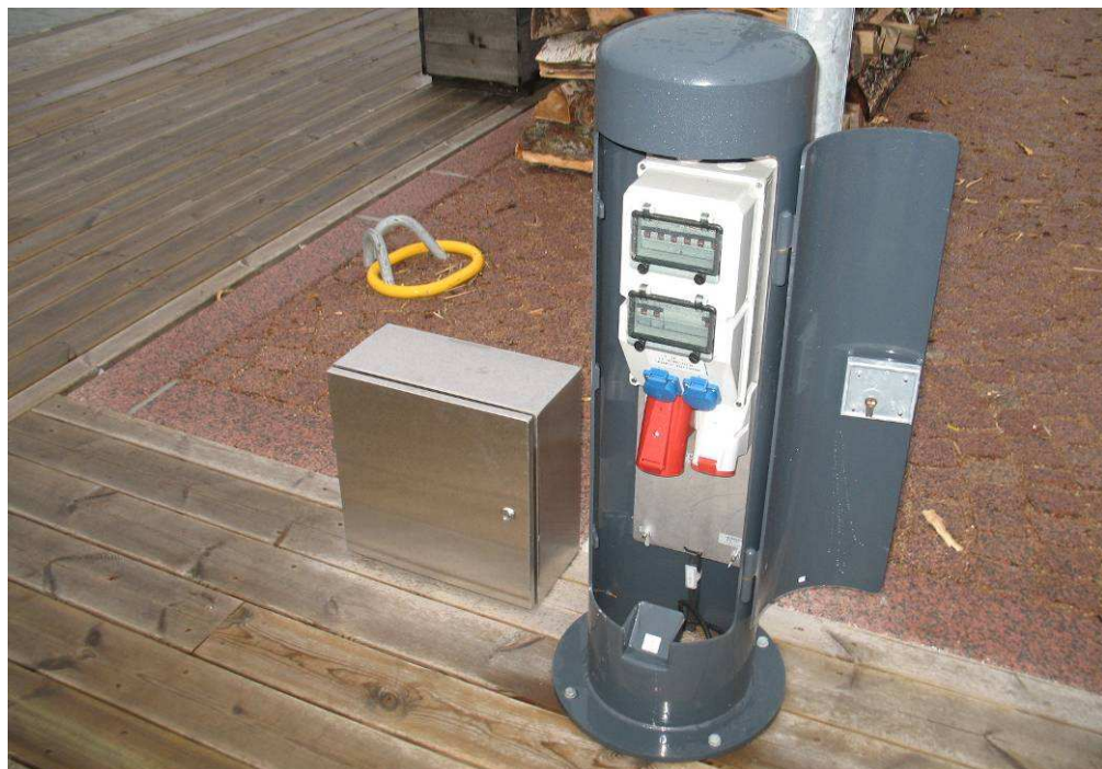
Kuva 29. Esimerkki sähköpisteestä sekä jätevedentyhjennyspisteestä Halkolaiturin osalta.
