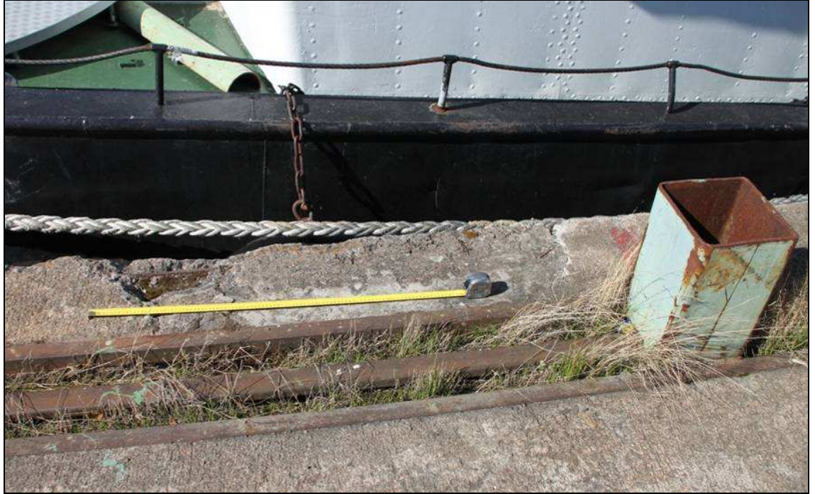
Kuva 15. Pollareiden ja kansirakenteen kunnostustarpeita.
