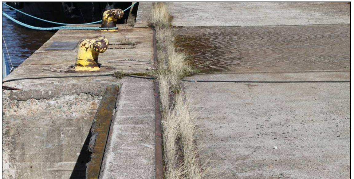
Kuva 14. Laiturin keskiosan pollarit, betonivaurioita, huonokuntoinen puuparru sekä kasvillisuutta.
