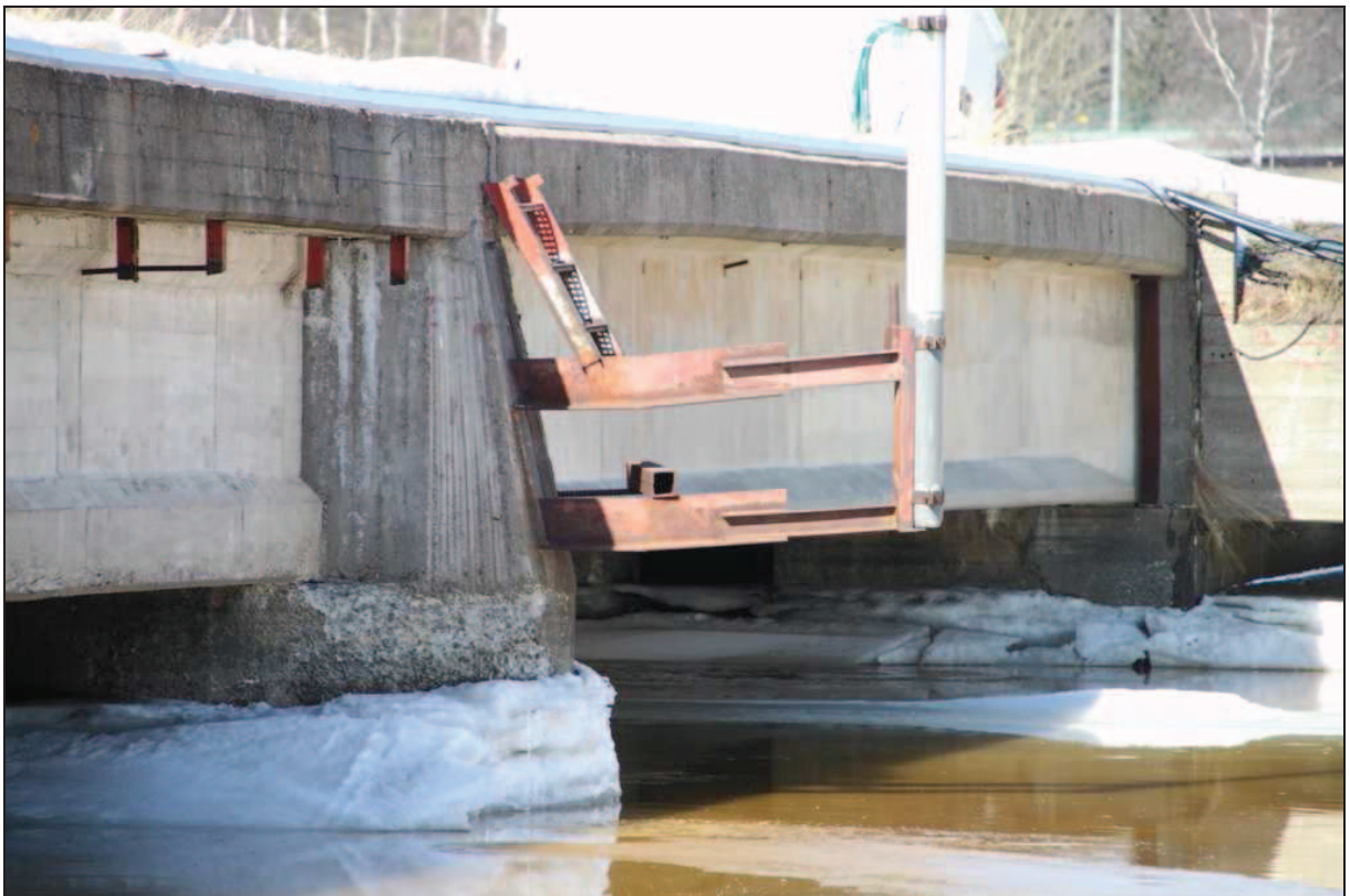
Kuva 22. Laiturin välipilari ja valaisinpylvään kiinnitys.
