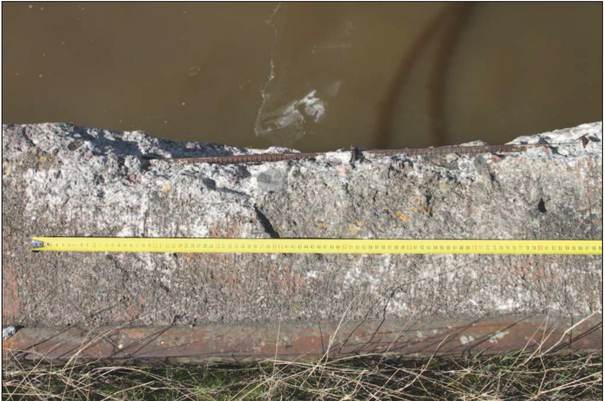
Kuva 11. Laiturin kannen betonivaurioita
