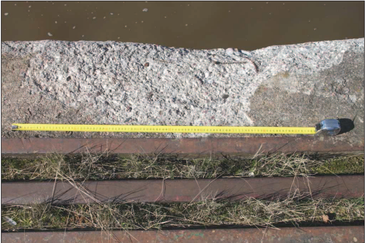
Kuva 9. Laiturin kannen betonivaurioita
