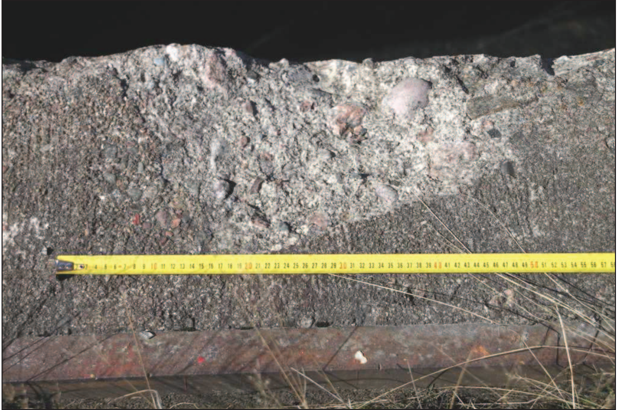
Kuva 13. Laiturin kannen betonivaurioita
