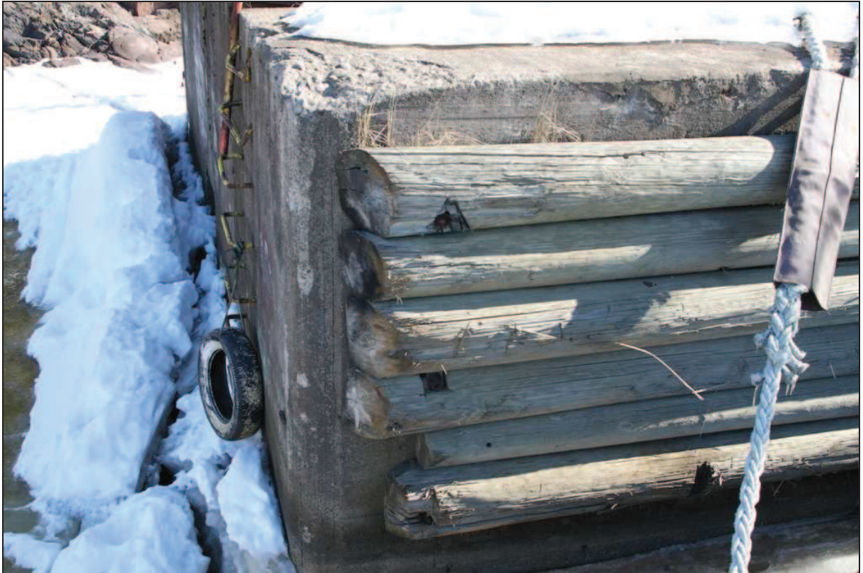
Kuva 19. Laiturin pohjoispäädyn puusuojaite ja pelastustikkaat.
