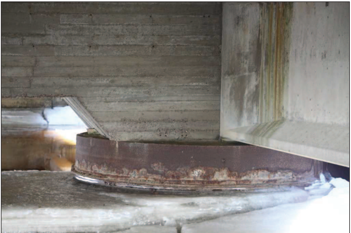
Kuva 24. Välipilarin teräsvahvistettu yläosa laiturin kannen alla.
