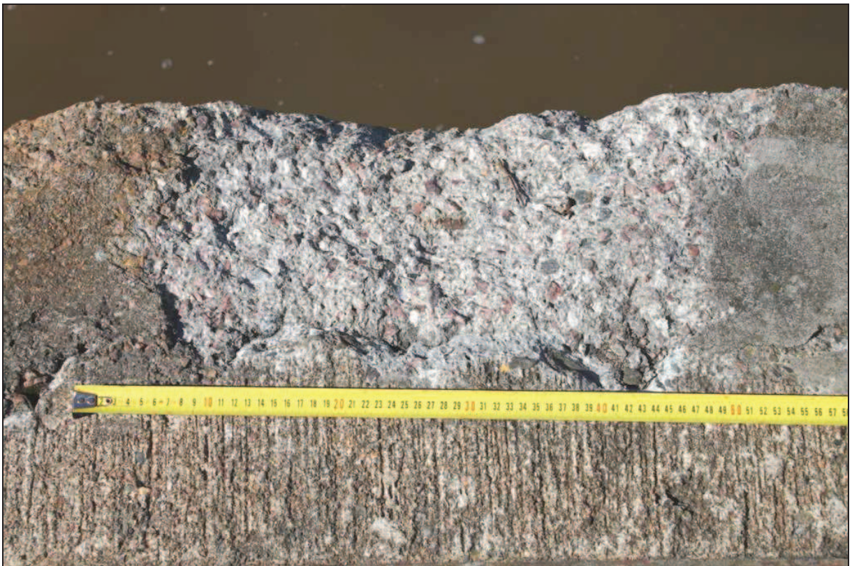
Kuva 10. Laiturin kannen betonivaurioita
