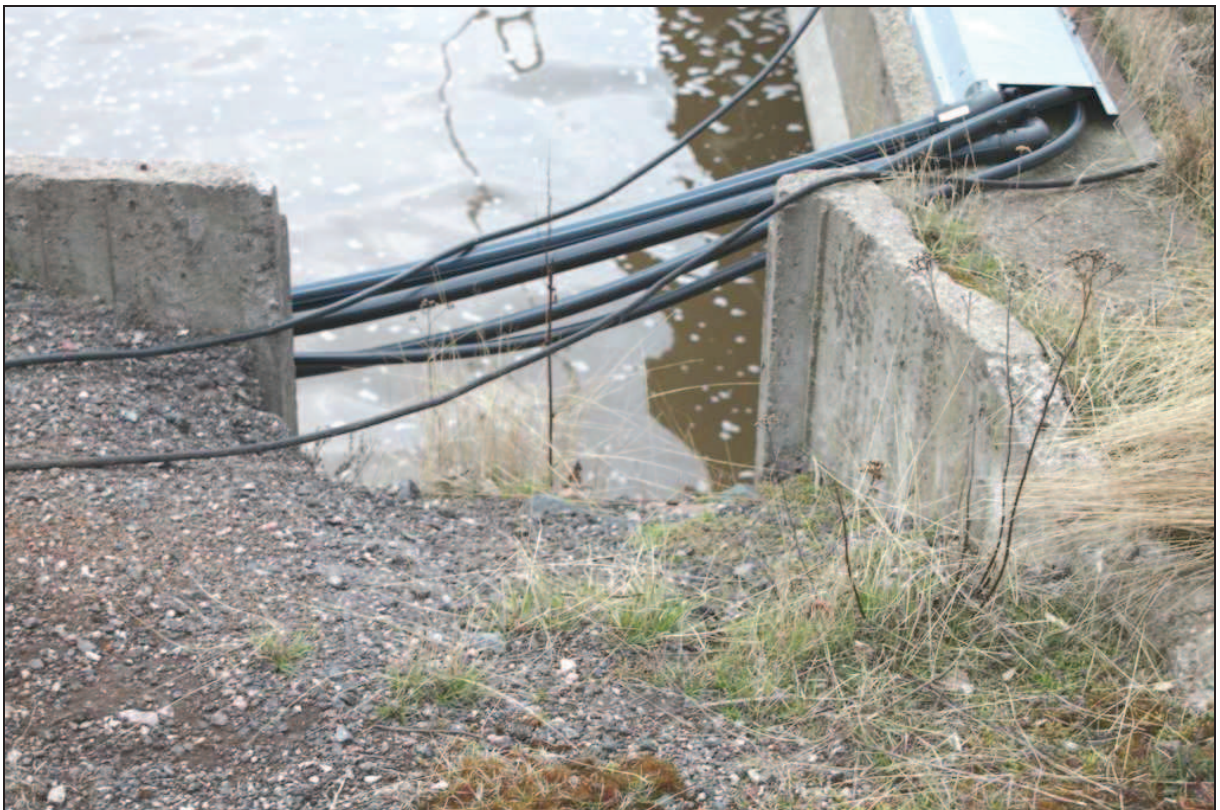
Kuva 18. Laiturin eteläpäädyn ponttonilaiturin septitankin imutyhjennyspisteelle (liikuntavirasto) johtavat vesi- ja viemäriputket sekä sähköjohdot.
