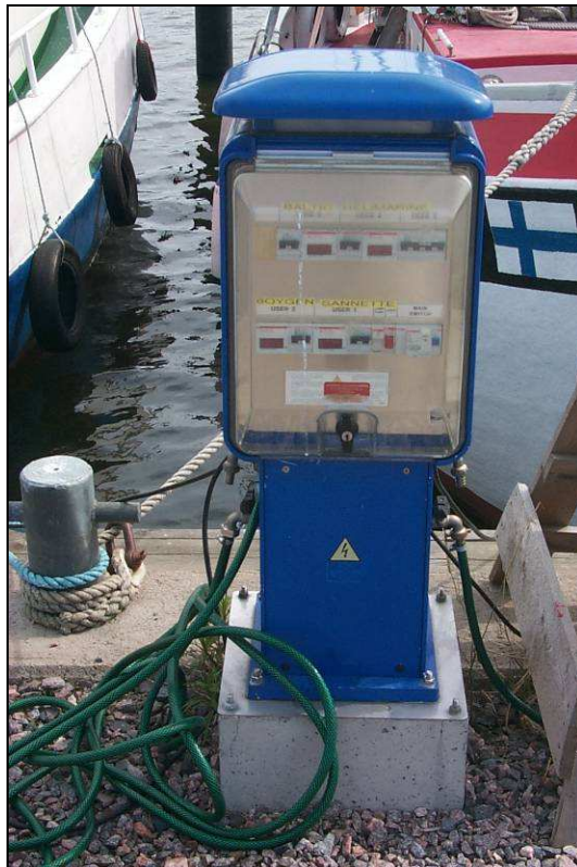
Kuva 24. Esimerkki yhdistetystä vesi- ja sähköpisteestä
