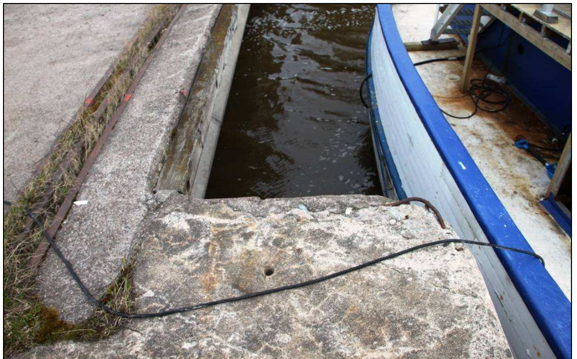
Kuva 12. Kannen betonivaurioita sekä huonokuntoinen suojalaitteena toimiva puuparru.
