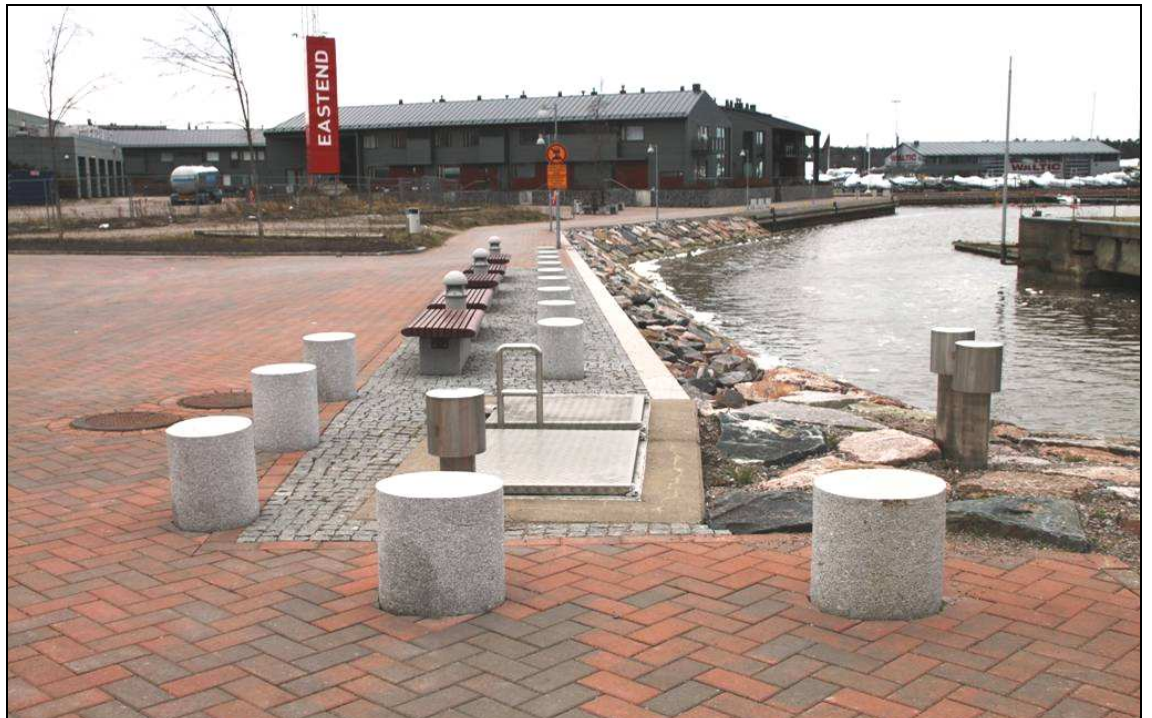
Kuva 26. Nykyinen jätevedenpumppaamo ja sen yhteydessä oleva tarkastuskaivo.
