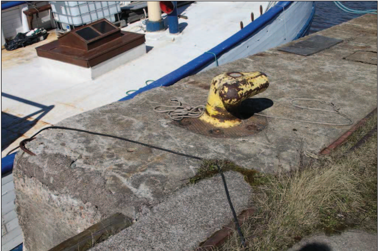
Kuva 7. Laiturin kannen betonivaurioita keskimmäisen arkun kohdalla.
