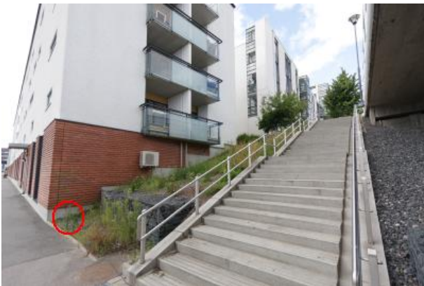
Mittauspisteet B4x, B5y ja B6z. Anturit on liimattu Tyynyläavantie 13:n kaakkoisnurkan sokkeliin.
