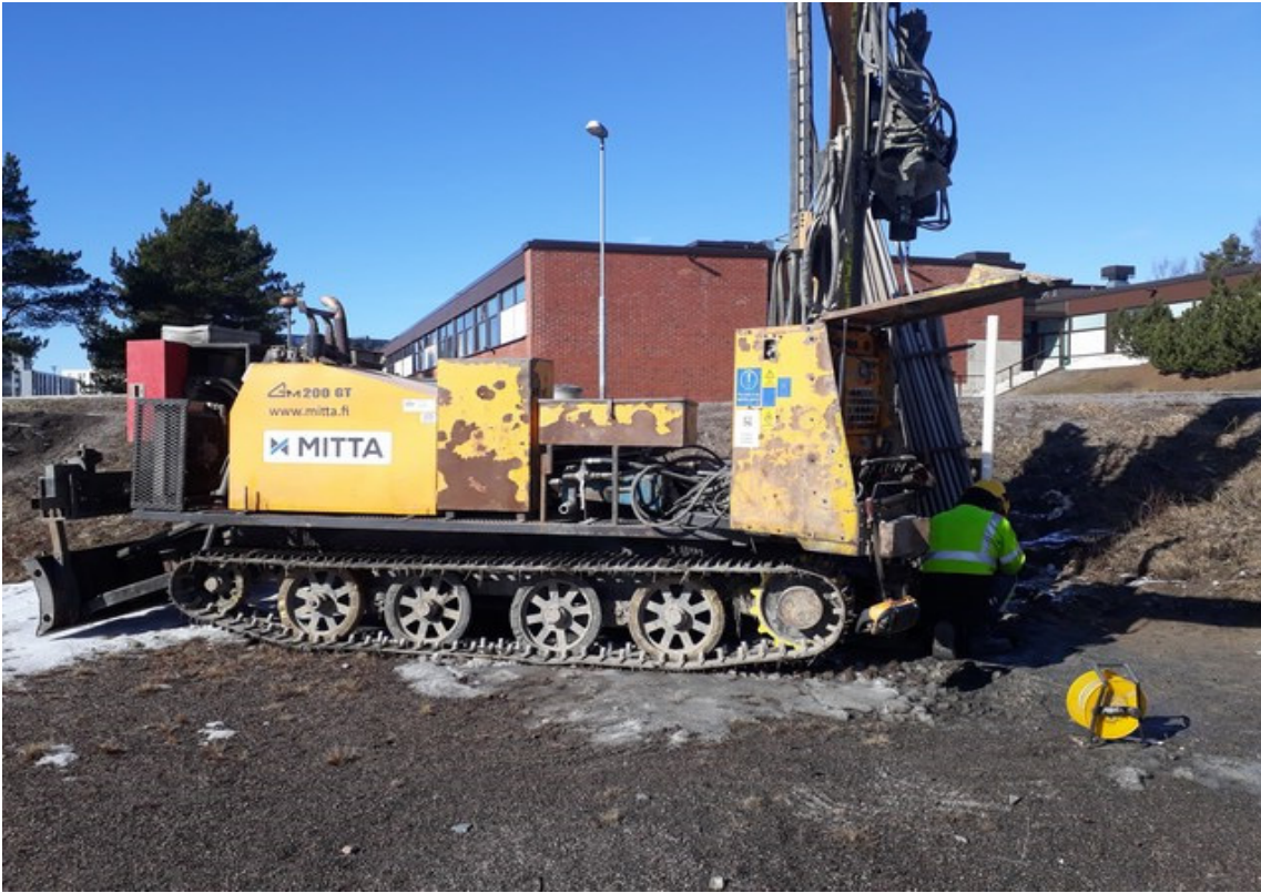
Kuva 8. Plt29.Tutkimuspisteellä S50 pohjavesiputken GA4 asennusta, kuvattuna länteen.
