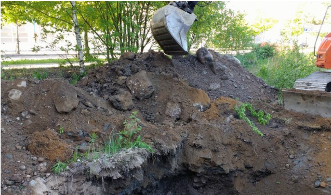
Kuva 1. Tlt7-9. Koekuopan KK11 kaivua, kuvattuna etelään Tyynylaavantien suuntaan.
