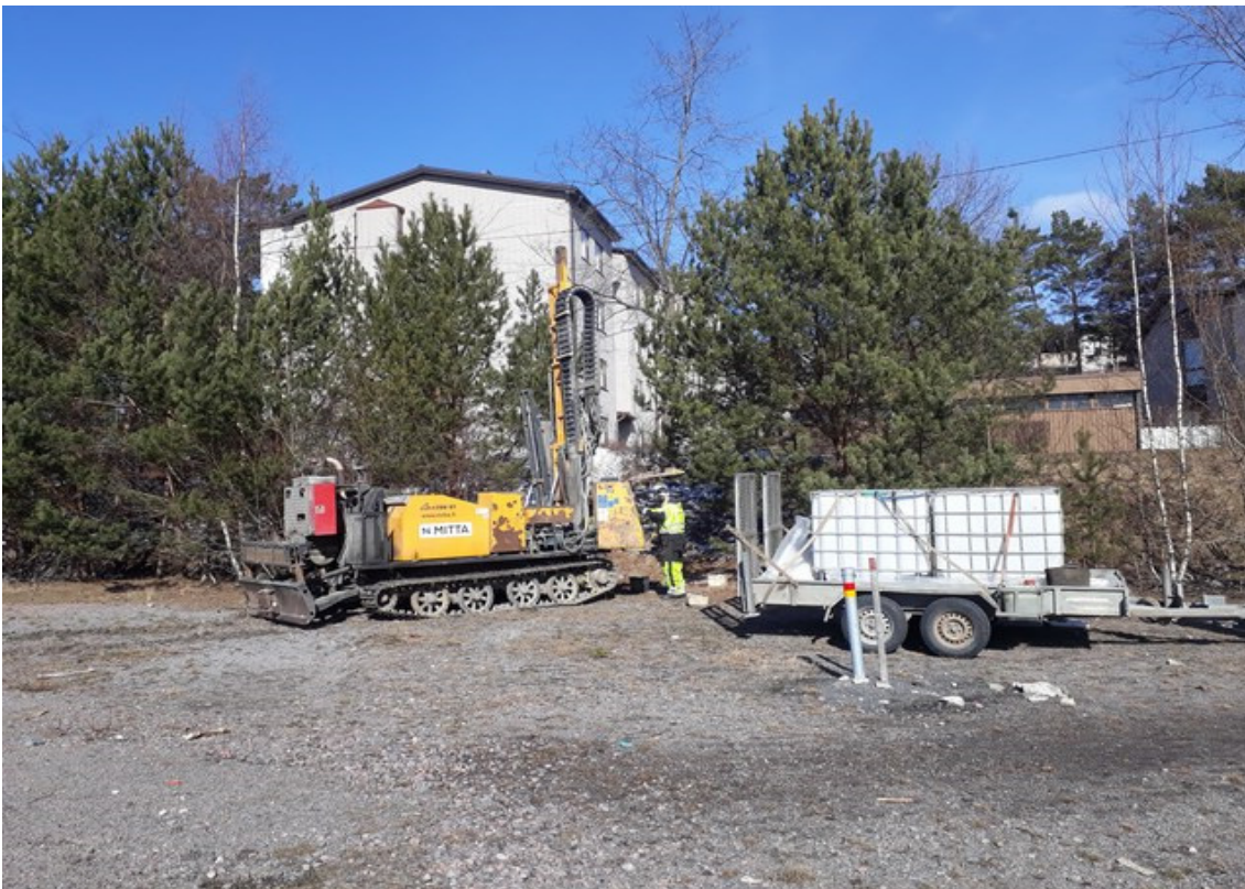
Kuva 9. Plt29.Tutkimuspisteellä S51, kuvattuna pohjoiseen.
