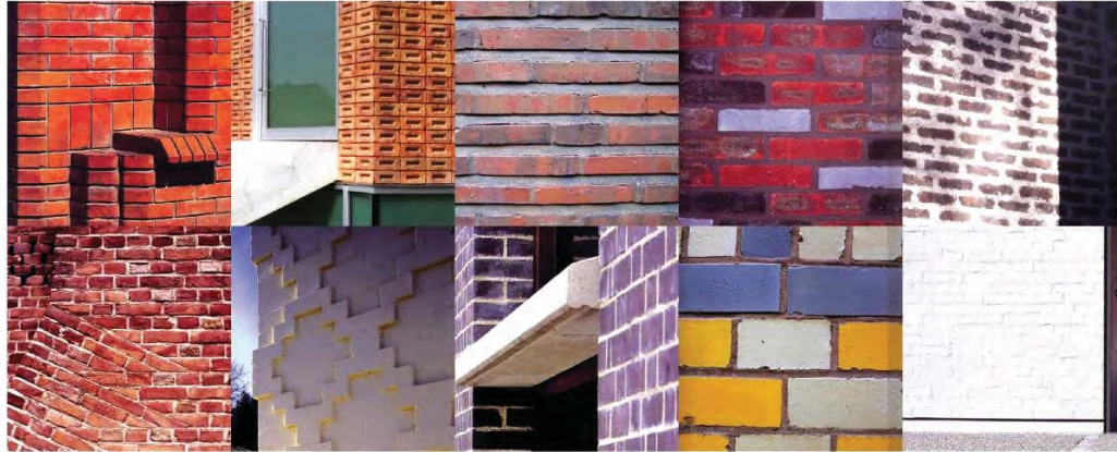
tiilen suunta muoto tiilen välillä muuraussauaman väri tiilen värjäys lasitteella ohutrappaus
