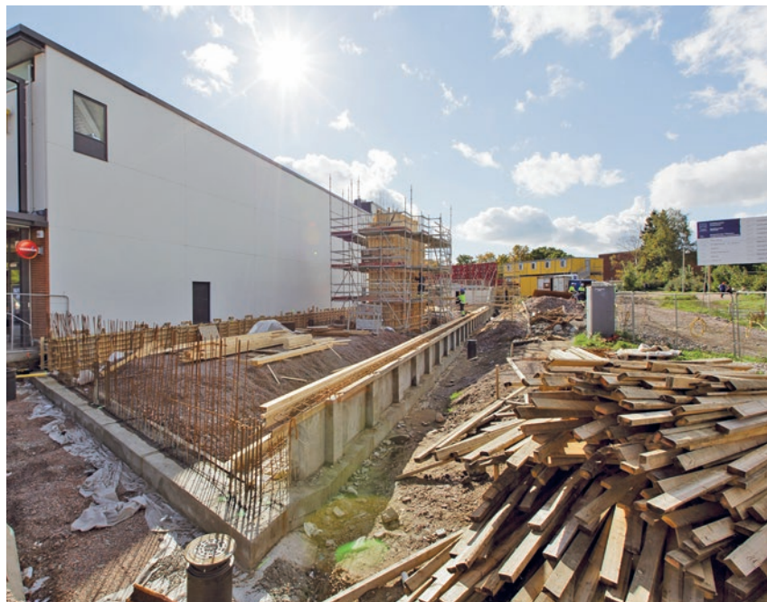
Maunula-talon rakentaminen oli vauhdissa syksyllä 2015. Maunulanpuiston laidalle nousevaan taloon rakennetaan tilat työväenopistolle, kirjastolle ja nuorisotalolle.
