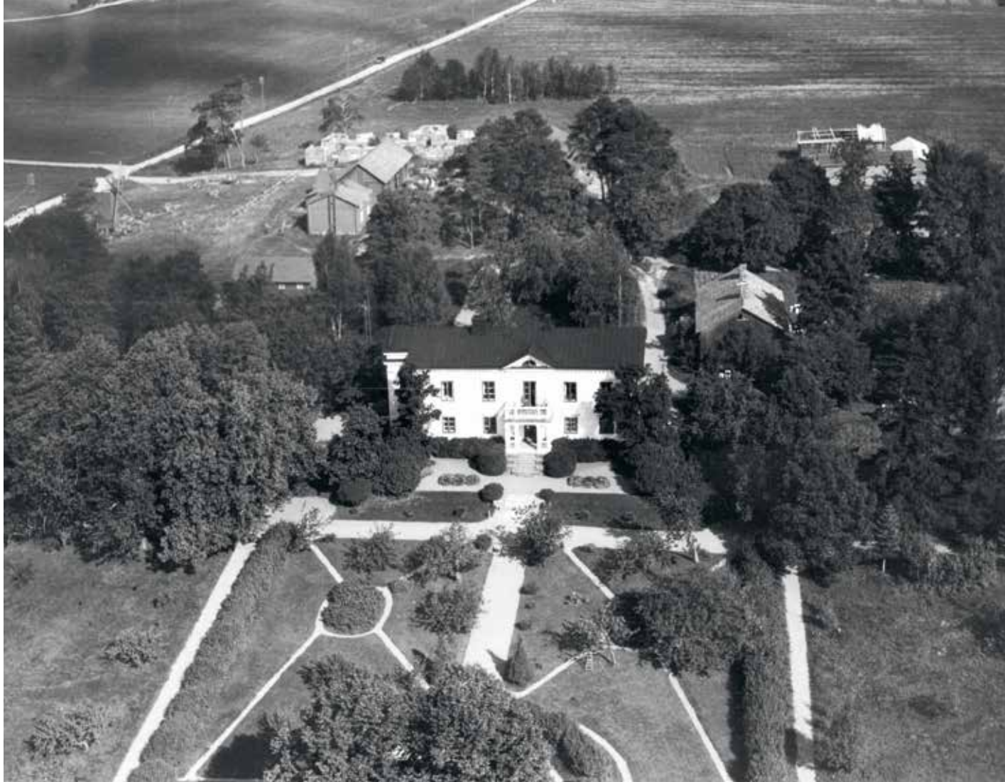
► Herttoniemen kartanorakennus ja sen yhteydessä ollut puisto jäivät Herttoniemen maakaupan ulkopuolelle. Etualalla näkyvä ranskalaistyyppinen muotopuutarha perustettiin Carl Olof Cronstedtin aikana 1800-luvun alkupuolella. Roos R. 1930.
