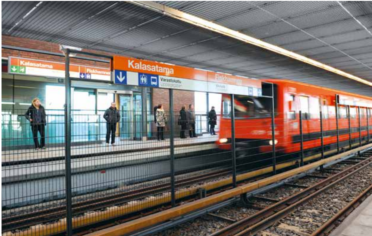
► Kalasataman metroasema otettiin käyttöön vuonna 2007. Kaupungin edullisesti toteuttamalla asemalla joudutettiin alueen toimitilatonttien rakentamista ja vuokraamista. Kiinteistöjalostuksella saavutettiin lähes win-win-tilanne – ratkaisun ”häviäjiä” olivat lähes tyhjällä asemalla vuosikausia pysähtymään joutuneet metromatkustajat. Kimmo Brandt 2011.
