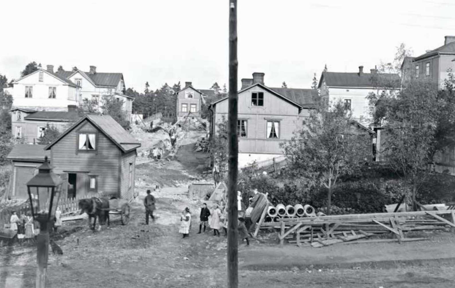
► Pasila liitettiin Helsinkiin vuoden 1912 alussa. Kaupunki kohensi välittömästi alueen infrastruktuuria ja liitti sen vesi- ja viemäriverkkoonsa. Työt käynnissä Leankadulla. Signe Brander 1912.
