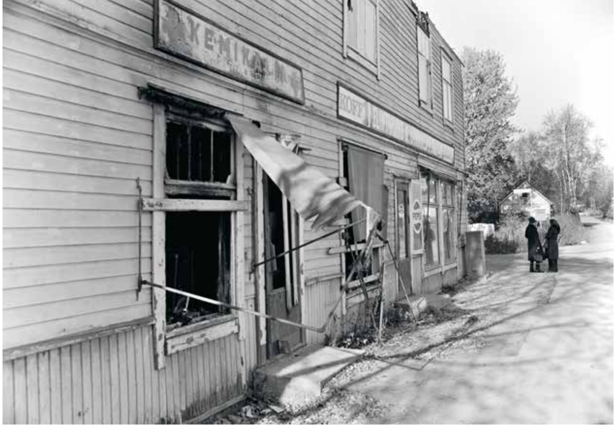
► O. Hännisen elintarvikeliike Malmiraitti 32:ssä odottamassa purkusaneerausta. Johnny Korkman 1979.
