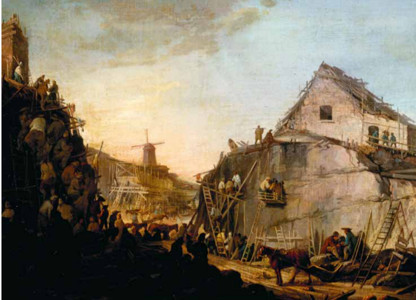
► Viaporin kaleeritelakan rakennustyöt ovat käynnissä Augustin Ehrensvärdin maalauksessa vuodelta 1763. Valtakunnallisesti merkittävälle merilinnoitukselle pakkolunastettiin Helsingiltä kuusi saarta. Niiden menetyksen korvasi kaupungin linnoitukselta saama voimakas kehitysimpulssi.
