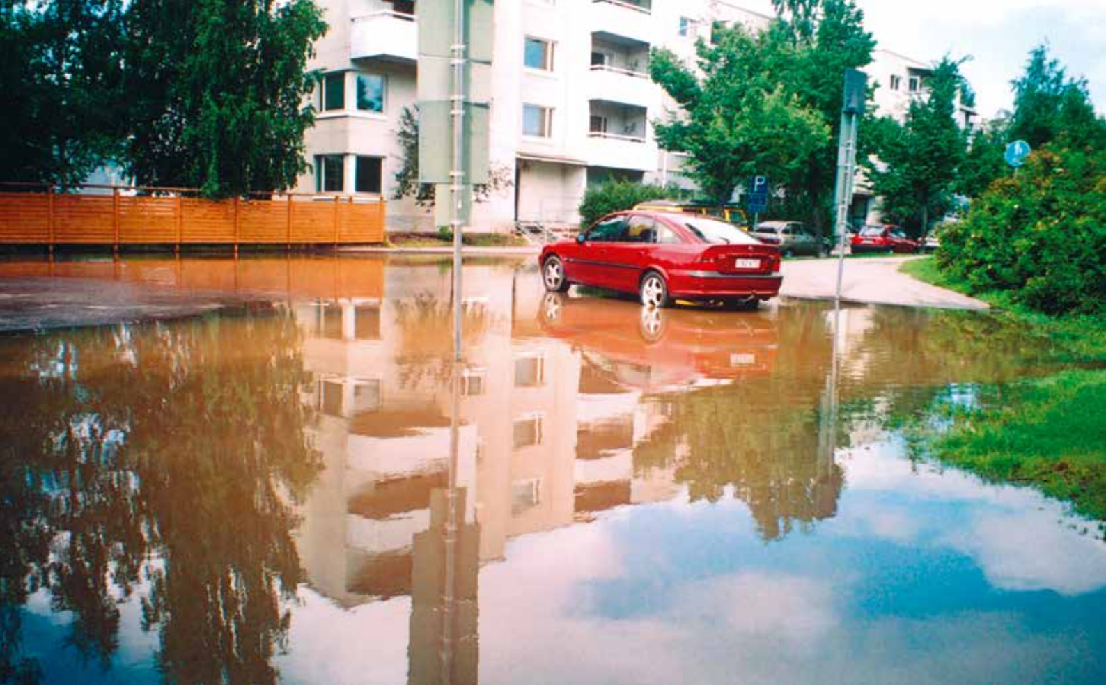
► Savela saneerattiin onnistuneesti käyttämällä hyväksi kiinteistönomistajien yhteistoimintasopimusta ja heiltä maat ostaneen rakentajan ja kaupungin välistä aluerakentamissopimusta. Vantaanjoki tulvi Savelan parkkipaikoille heinäkuussa 2004. Asuinalueen alttius tulville oli tiedossa ja sitä oli myös suojattu tulvavallein. Aarno Laurila 2004.
