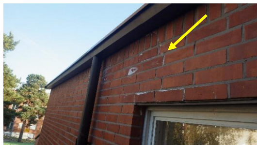
Kuva 23. Vesikatoilla ei ole käytännössä lainkaan räystäitä. Räystäskourut ovat aivan kiinni ulkoseinässä. Kuvassa räystäskourun tulvinta on kastellut julkisivua. Lähtötietojen mukaan räystäskouruja on uusittu lähivuosina. Räystäskourujen korjauksilla on saatu vesikattovuodot ulkoseinälinjoilla hallintaan.
