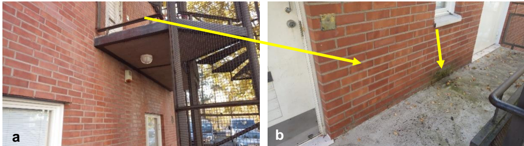
Kuvat 17a ja b. IV-konehuoneen käyntisillan alapuolella julkisivun tiilimuurauksessa on valumavesien aiheuttamia kosteusjälkiä. Käyntisillan päällä on havaittavissa vesien lammikoitumisen viittaavia jälkiä.
