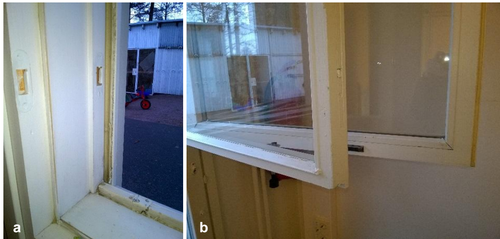
Kuvat 13a ja b. Ikkunoiden käynneissä todettiin monin paikoin puutteita. Osa pistokoeluonteisesti tarkastetuista ikkunoista oli todella hankala saada auki. Muuten ikkunat olivat hyväkuntoisia
