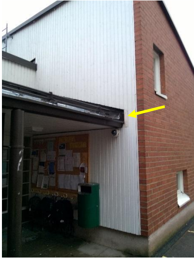
Kuva 24. Sisäänkäyntien katosten pellitykset ja räystäskourut on upotettu lautaverhoillun julkisivun sisään. Rakennuksen sisä- tai ulkopuolelta ei havaittu viitteitä ko. liitoksen aiheuttamista vuodoista. Liitosta voidaan kuitenkin pitää riskialttiina, etenkin jos räystäskouruja ei tyhjennetä riittävän usein.
