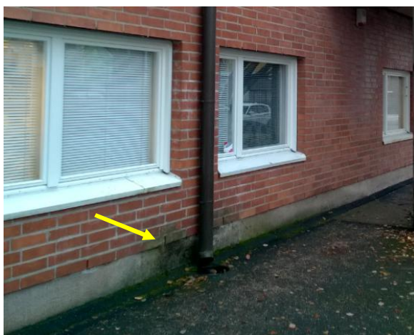
Kuva 16. Syöksytorven roiskevesien aiheuttamaa vanhaa sammaloitumista ja julkisivupinnan likaantumista. Julkisivun tiiliverhouksen joka kolmas pystytiilisauma on avoin.
