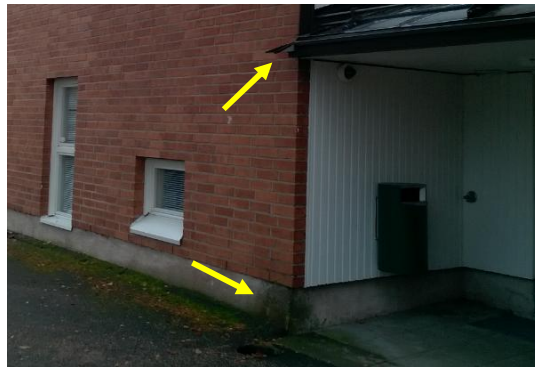
Kuva 22. Sisäänkäyntikatoksen lipan sadevedenpoistojärjestelmän roiskevedet ovat värjänneet julkisivun alaosa. Osassa katoksia räystäskourusta puuttuu kuvan mukaisesti syöksytorvi ja sadevedet johdetaan alas ulosheittäjällä.
