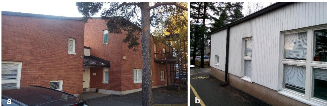
Kuvat 14a ja b. Julkisivut ja ikkunat ovat pääosin siistissä kunnossa. Kuvan 14b puuverhouksessa on nähtävissä kesällä 2016 uusitun julkisivun ja vanhemman osan raja.
