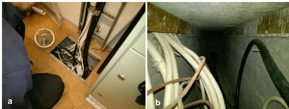
Kuvat 6a ja b. Sähköpääkeskuksessa on betonirakenteinen kanaali alapohjassa sähköjohtoasennuksia varten. Tarkastusluukusta (ei ilmatiivis) arvioiden kanaalin rakenteet vaikuttivat kuiltä eikä sieltä aistittu normaalista poikkeavia hajuja. Kanaalissa on vähän kuivaa muottilautaa.
