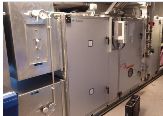
Kuva 3. TK201/PK201 on Systemairin valmistava pakettikone.
