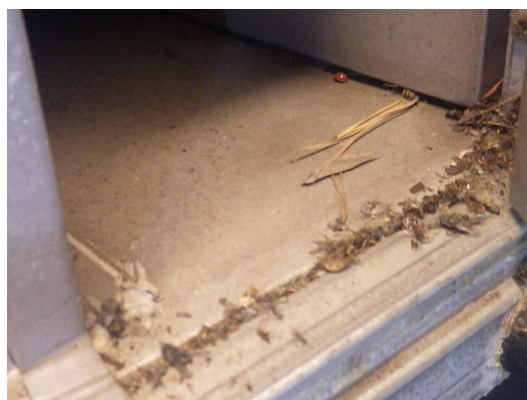
Kuva 7. Raitisilmakammiossa oli runsaasti ulkoilmaepäpuhtauksia.
