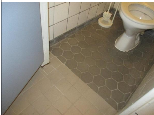
Itäsiiven erillis-wc:n keraaminen laatoitus
