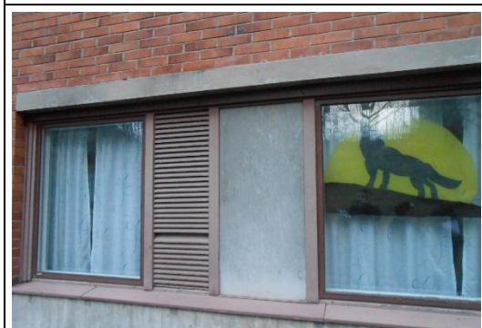
Ikkunoiden välisen pilarin kotelointi
