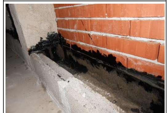
Yläpohjatilan bitumikermikouru
