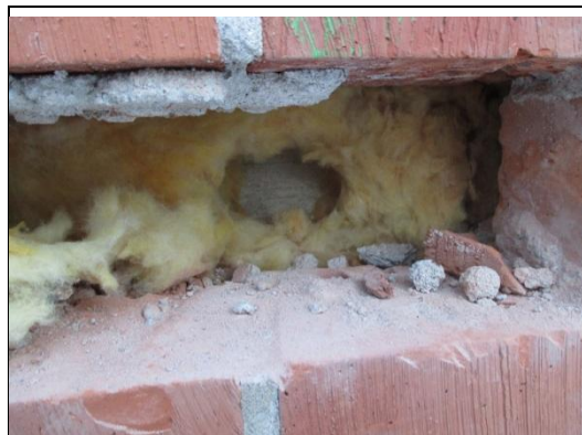
Ulkoseinän rakenneavaus
