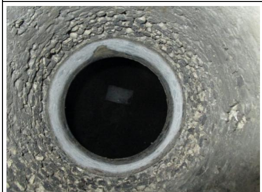
Alapohjan lämmöneristekerros (leca-betoni) ja kantava teräsbetonilaatta
