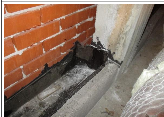
Bitumikermikouru loppuu pilarin kohdalla
