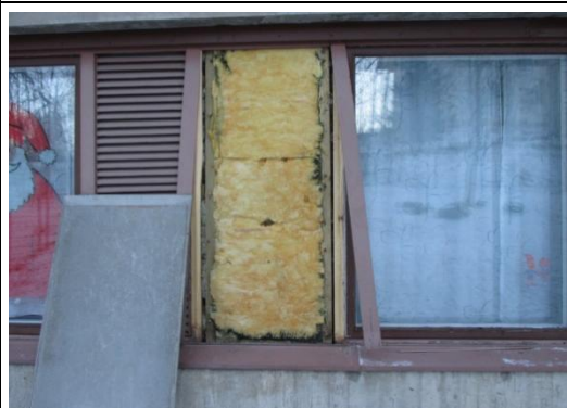
Ikkunan ja pilarin kotelorakenteen avaus
