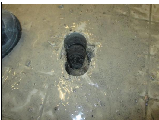
erillis-wc-tilojen osittainen rakenneavaus, pintalaattojen välissä bitumieristekerros
