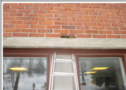
Palkin ja ulkoseinän liittymärakenteen avaus
