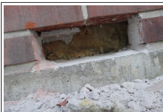
Sokkelin liittymärakenteen avaus
